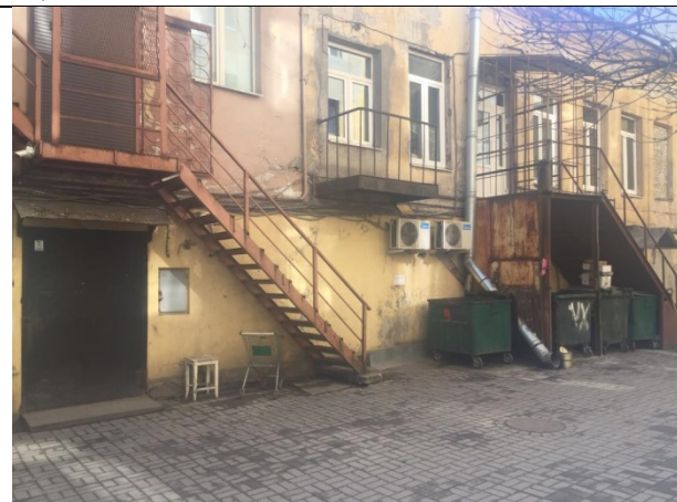
Фото 19. Внутри дворовая территория Объекта оценки
