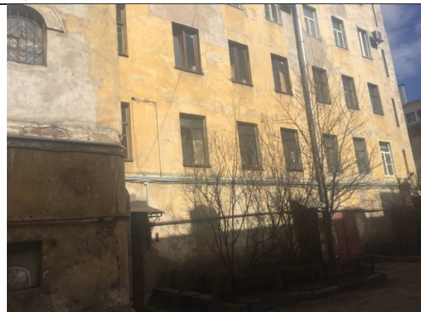
Фото 20. Вид здания Объекта оценки
