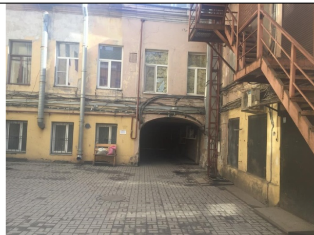
Фото 17. Внутри дворовая территория Объекта оценки
