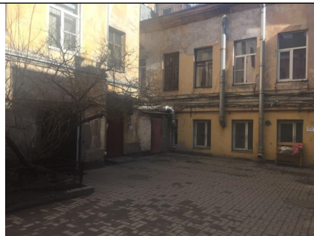
Фото 18. Внутри дворовая территория Объекта оценки
