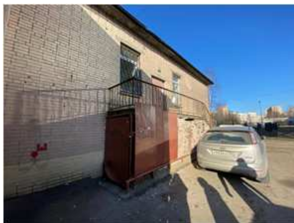
Фото 3. Вид здания, в котором расположен Объект оценки, со двора Характеристика входной группы и оконных проемов
