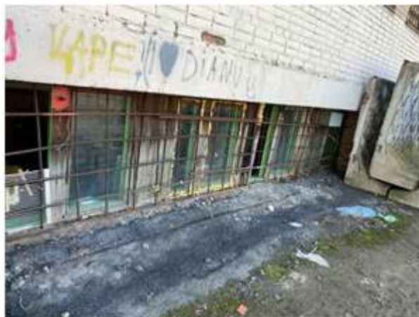
Фото 9. Вид окон Объекта оценки, со двора
