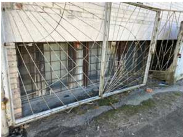
Фото 8. Вид окон Объекта оценки, со двора
