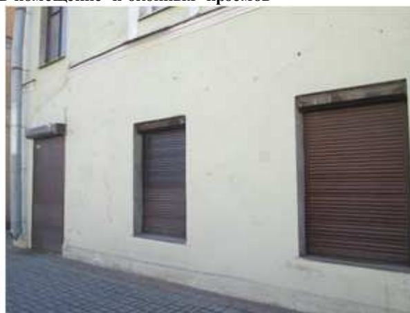
Фото 12. Отдельный вход и окна, с улицы
