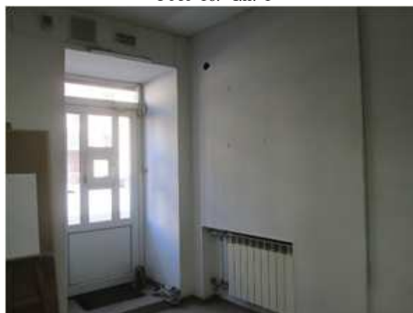
Фото 18. Ч.п. 1 (отсутствует оконный проем, по плану)
