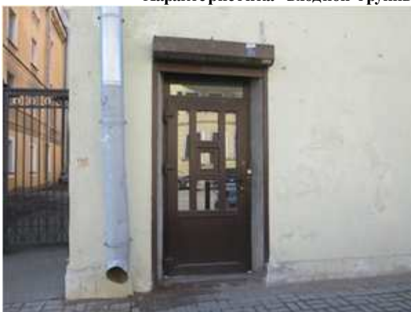
Фото 11. Отдельный вход с улицы
