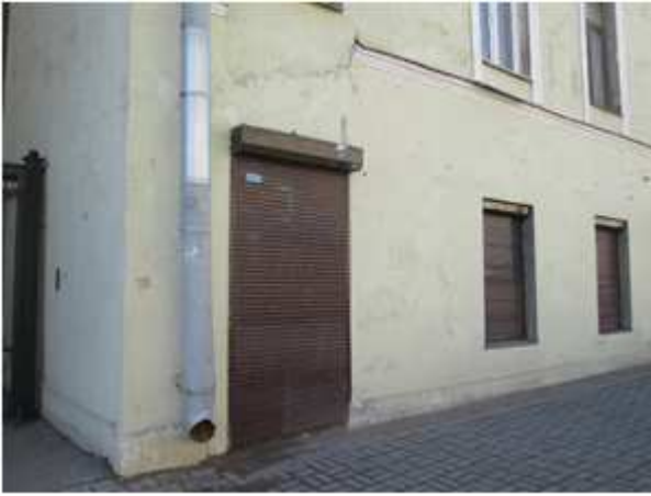
Фото 13. Отдельный вход и окна, с улицы
