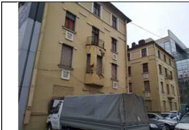
Фото №9: Фасад здания
