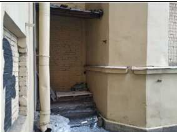
Фото №7: Заложенный вход в здание
