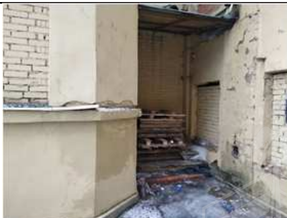
Фото №8: Заложенный вход в здание
