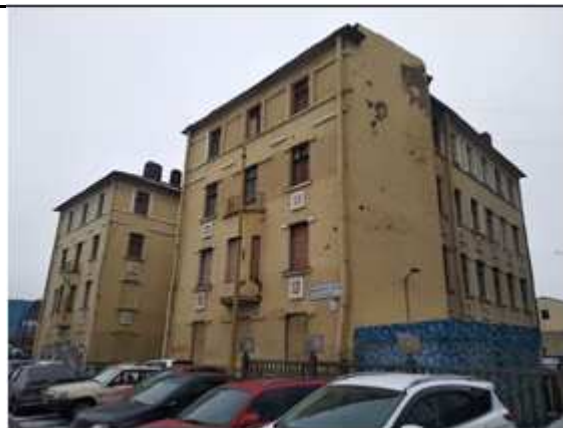
Фото №10: Фасад здания
