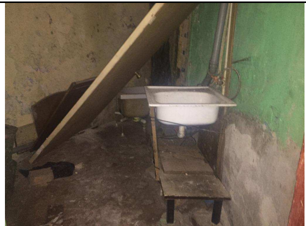
Фото 30. Типичное состояние Объекта оценки
