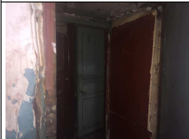
Фото 27. Типичное состояние Объекта оценки
