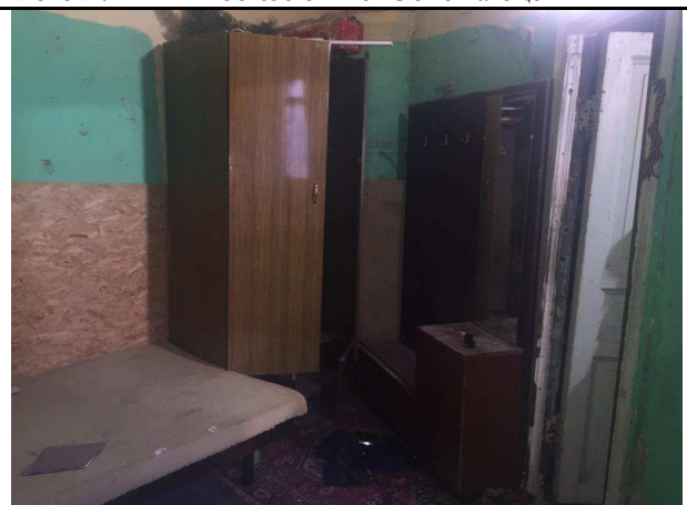
Фото 26. Типичное состояние Объекта оценки
