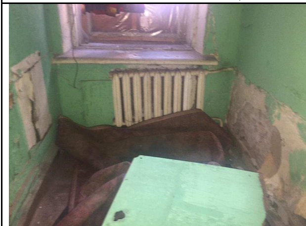
Фото 23. Типичное состояние Объекта оценки
