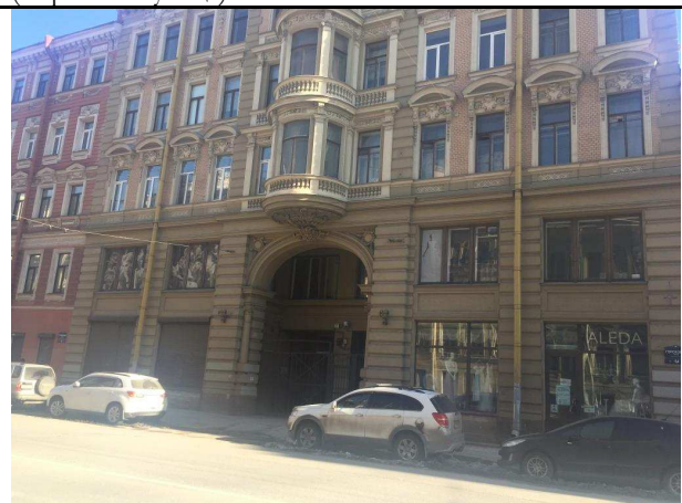
Фото 8. Вид здания Объекта оценки
