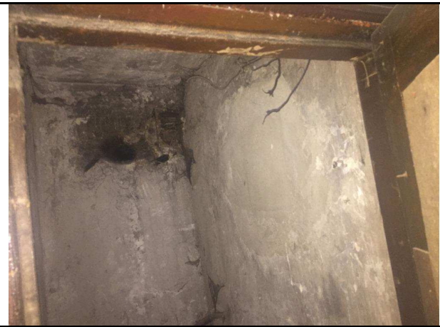
Фото 28. Типичное состояние Объекта оценки
