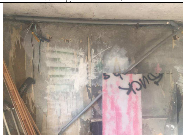
Фото 24. Типичное состояние Объекта оценки
