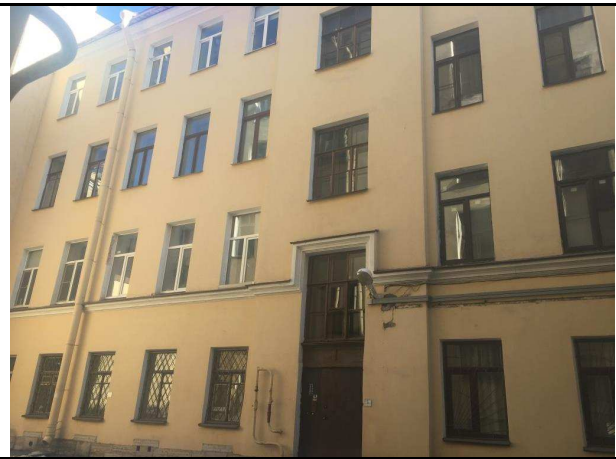
Фото 12. Вид здания Объекта оценки
