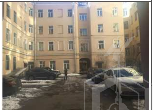
Фото 8. Вид здания Объекта оценки
