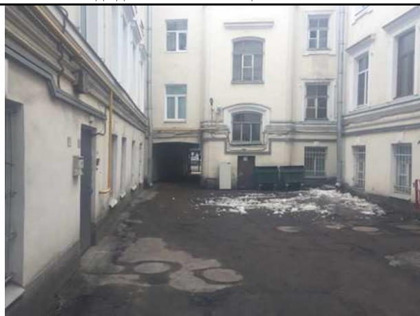
Фото 15. Вид здания Объекта оценки
