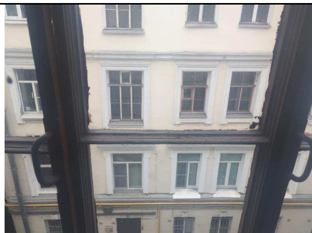
Фото 30. Типичное состояние Объекта оценки
