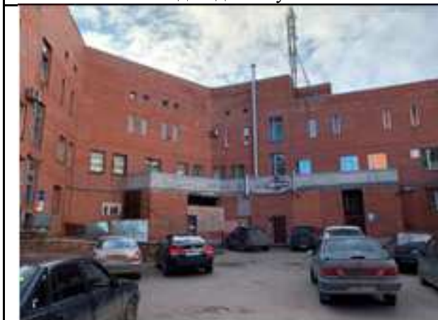
Фото 9 Вид фасада здания, в котором расположен объект оценки, со стороны двора
