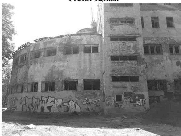
Фото 4. Вид здания, в котором расположен Объект оценки
