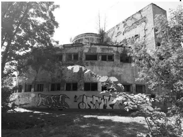
Фото 1. Вид здания, в котором расположен Объект оценки
