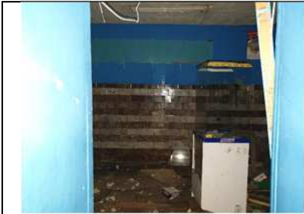
Фото № 7 - Внутренне состояние
