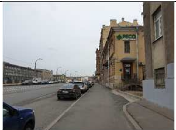
Фото № 18 - Фасад здания
