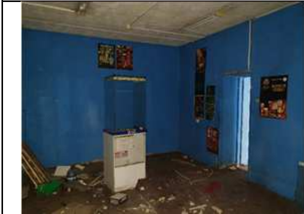
Фото № 9 - Внутренне состояние
