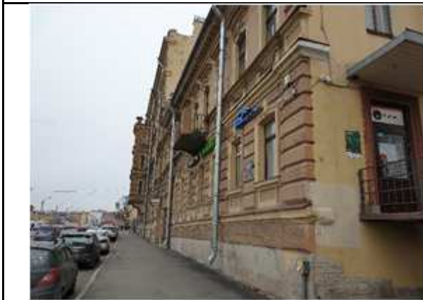
Фото № 17 - Фасад здания
