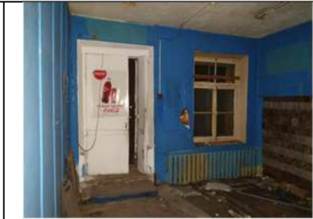
Фото № 8 - Внутренне состояние
