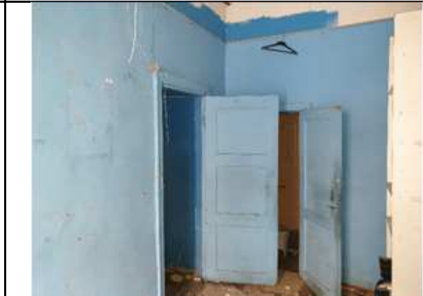
Фото № 10 - Внутренне состояние
