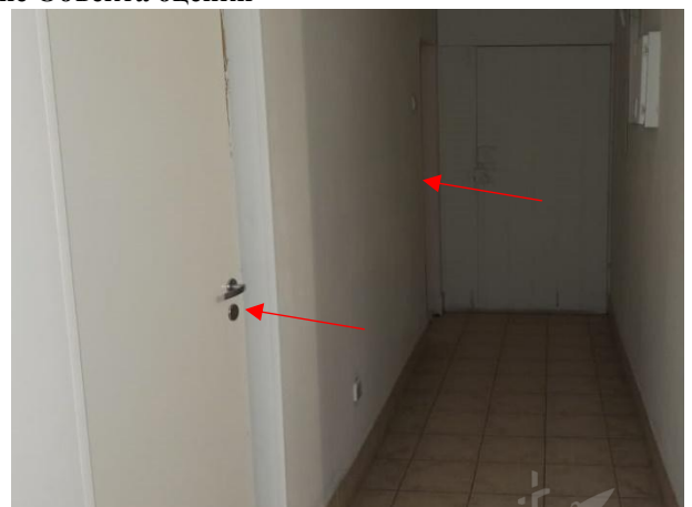
Фото 12. 2 входа в пом. 3-Н из общего с нежилыми помещениями коридора
