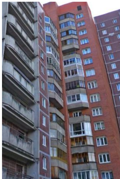
Фото 2. Вид здания, в котором расположен Объект оценки, со двора
