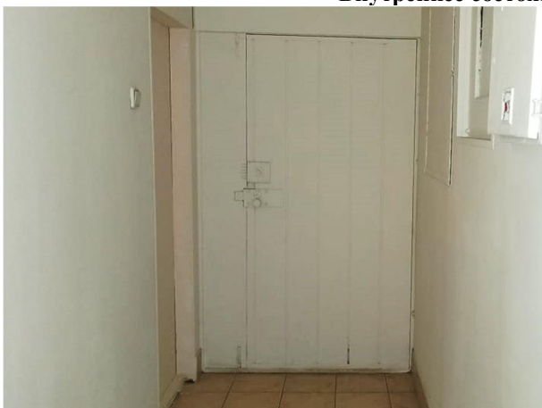
Фото 11. Общий вход с нежилыми помещениями со двора (дверной проем закрыт – вид изнутри)
