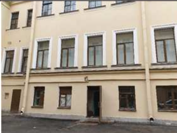
Фото № 19 - Внутренне состояние
