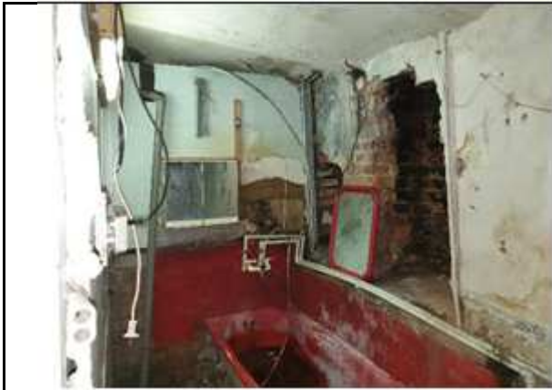
Фото № 17 - Внутренне состояние
