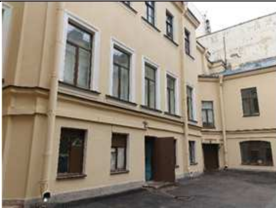
Фото № 1 – Вход в помещение
