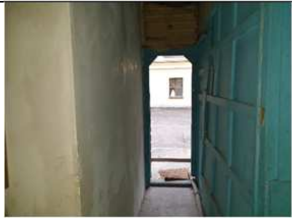
Фото № 18 - Внутренне состояние
