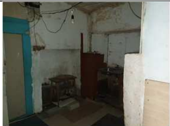
Фото № 6 - Внутренне состояние
