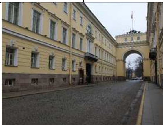
Фото № 23- Фасад здания
