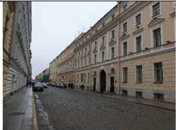
Фото № 22 - Фасад здания
