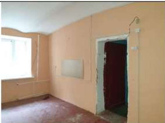
Фото № 15 - Внутренне состояние
