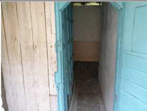
Фото № 5 - Вход в помещение
