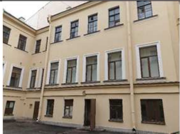
Фото № 2 - Вход в помещение
