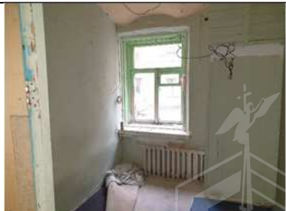
Фото № 8 - Внутренне состояние
