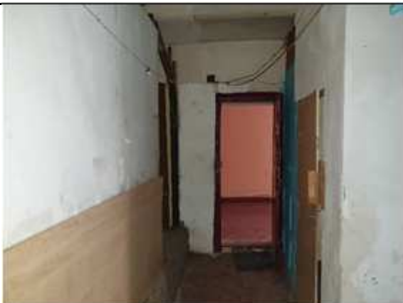
Фото № 7 - Внутренне состояние
