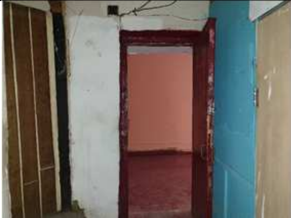
Фото № 11 - Внутренне состояние
