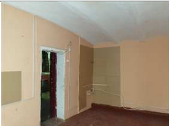
Фото № 13 - Внутренне состояние
