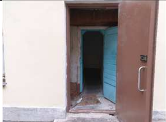
Фото № 4 - Вход в помещение
