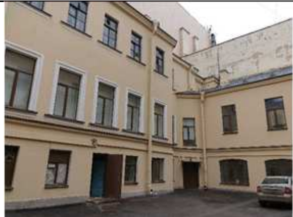
Фото № 20 - Внутренне состояние
