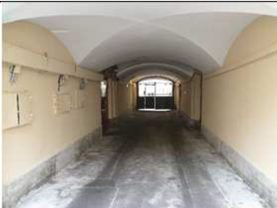
Фото № 21 - Проход к помещению с улицы Галерная
