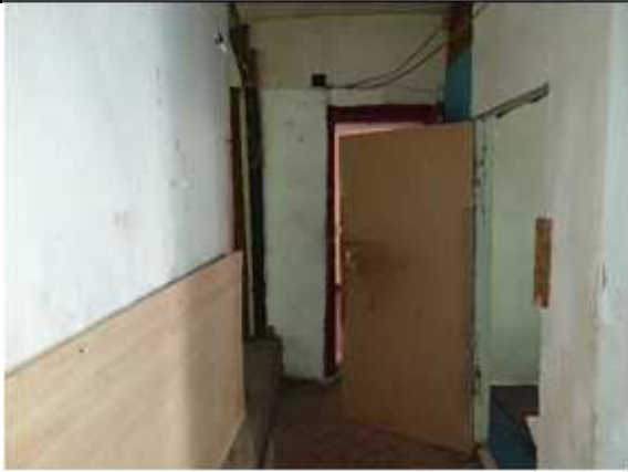
Фото № 9 - Внутренне состояние
