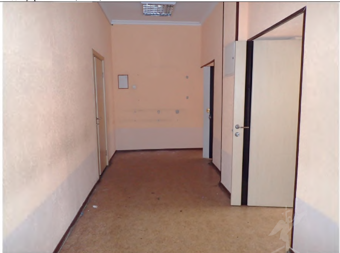
Описание: Вид внутри Объекта (ч.п. 3)
