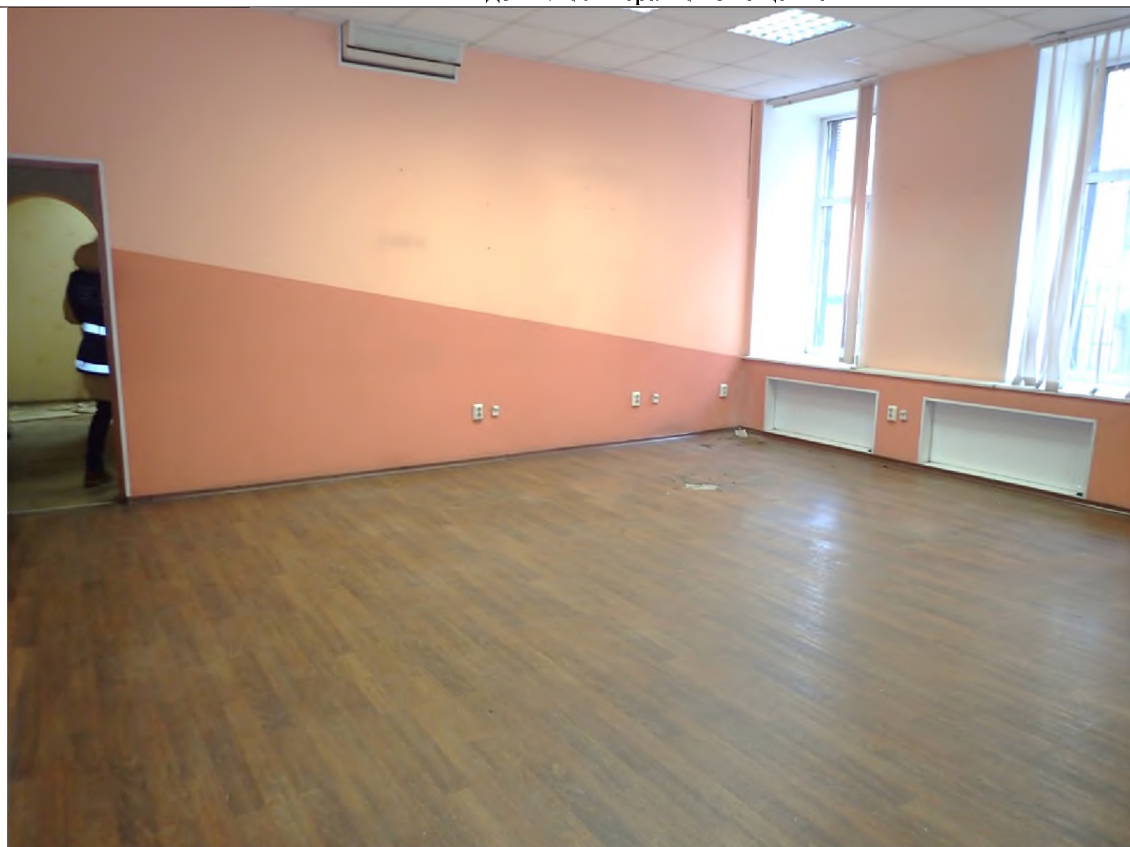
Описание: Вид внутри Объекта (ч.п. 5)
