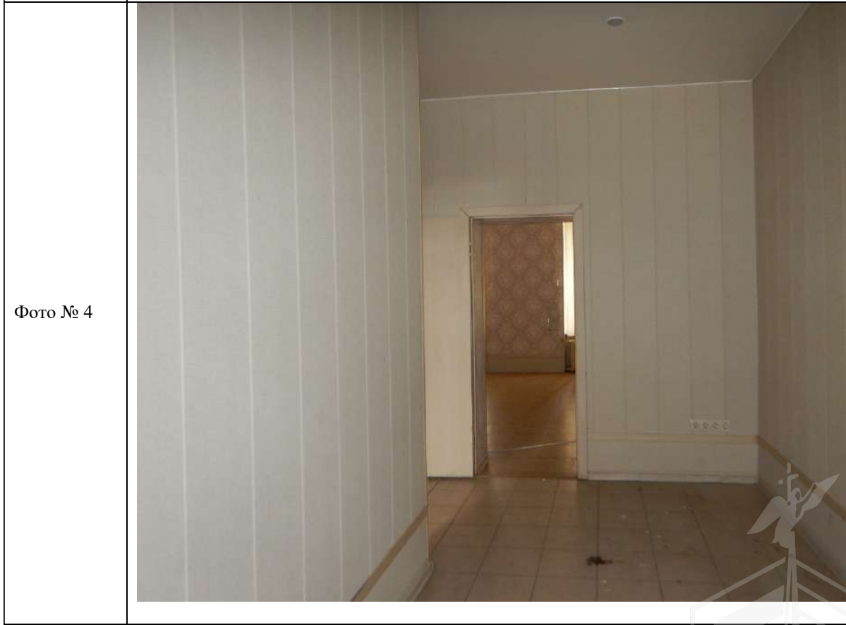
Описание: установлена перегородка в ч.п. 11
