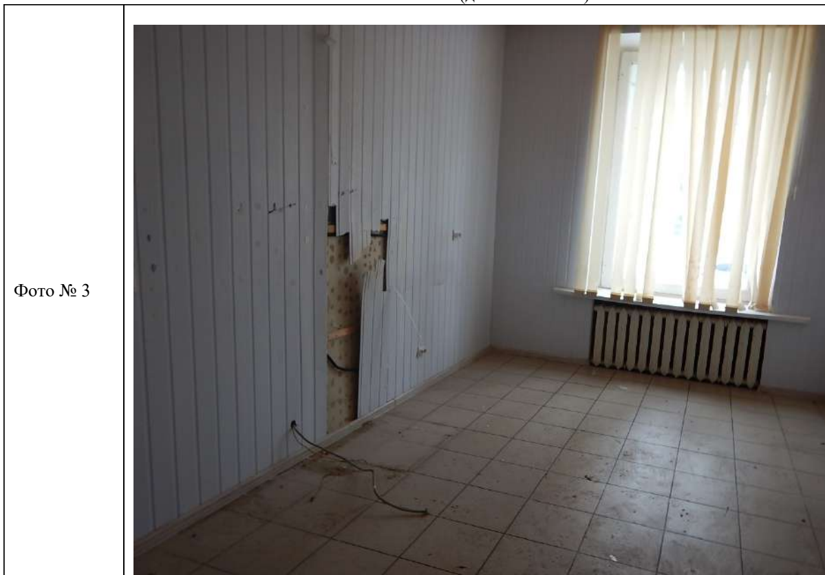
Описание: демонтированы перегородки между ч.п. 3 и ч.п. 11
