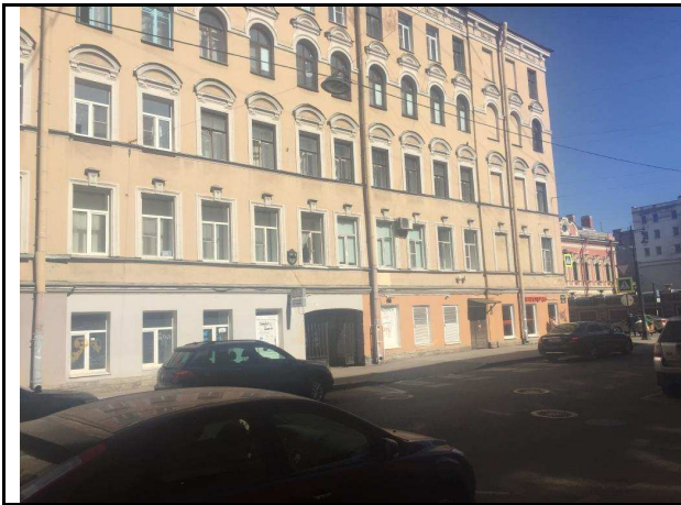
Фото 9. Вид здания Объекта оценки
