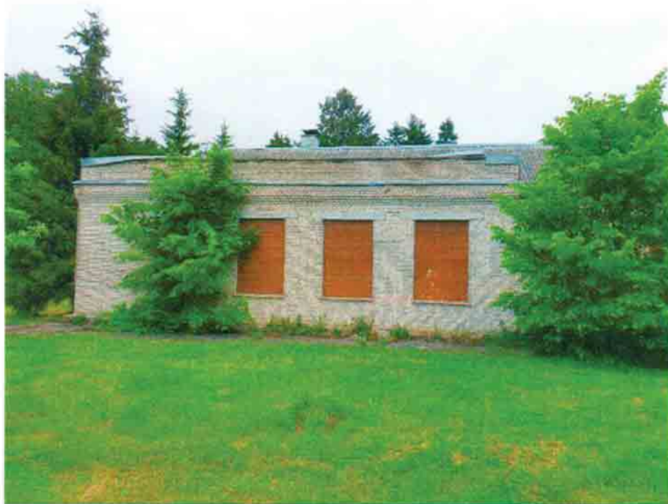
Общий вид. Фасады в осях А-Г.
