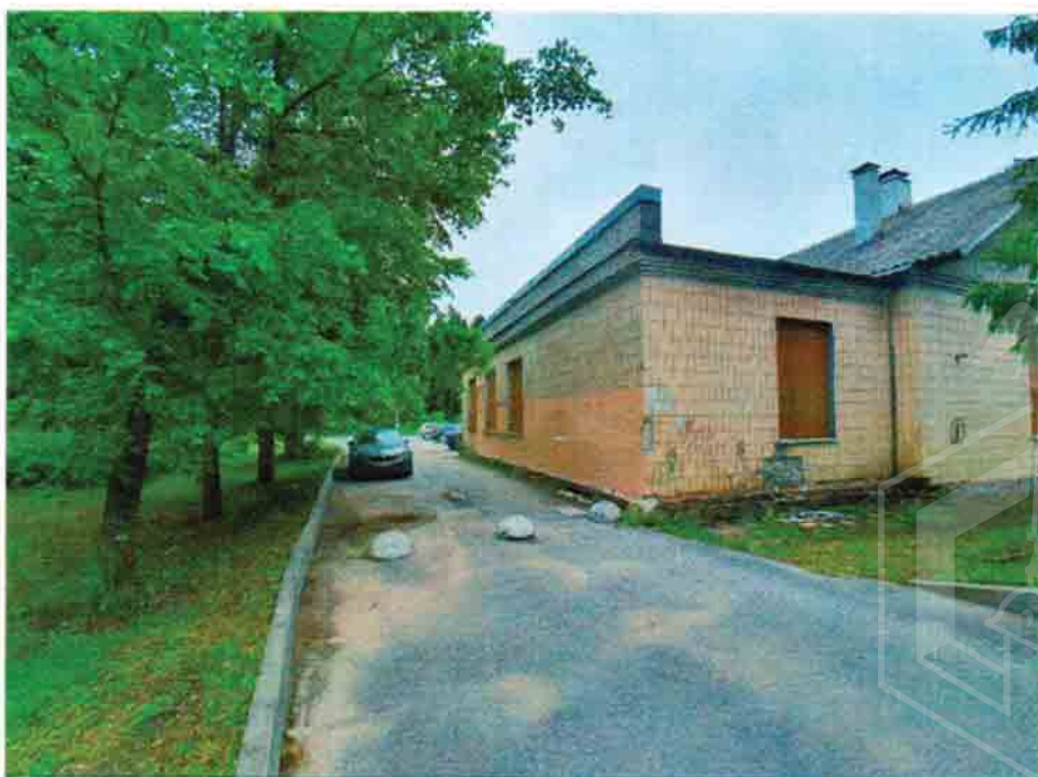
Общий вид. Фасады в осях В-А.
