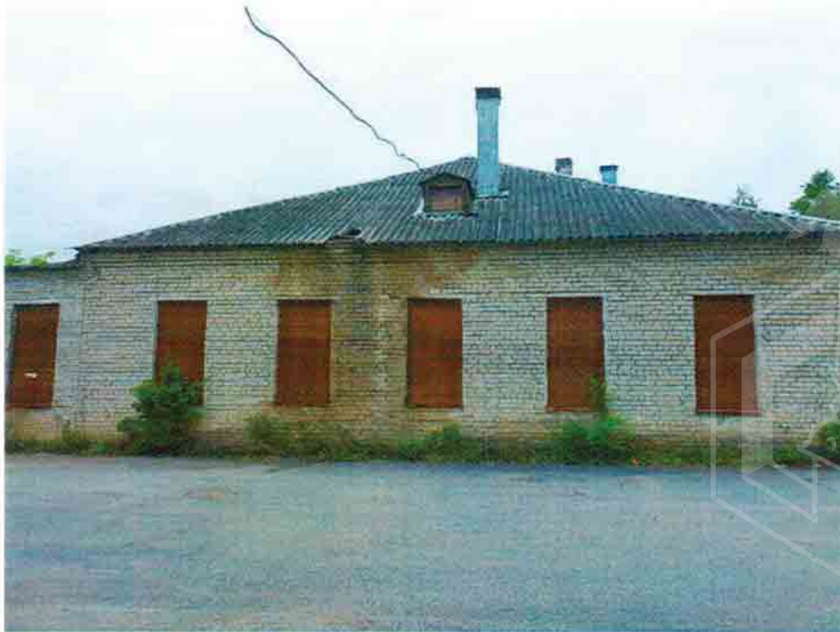
Общий вид. Фасады в осях 1-6.
