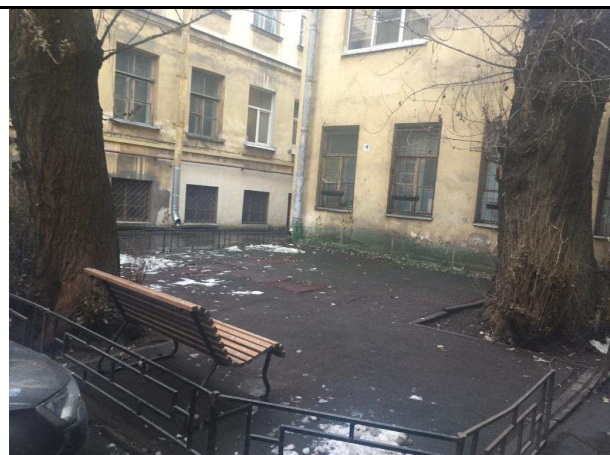
Фото 10. Вид на двор дома, в котором расположен Объект оценки
