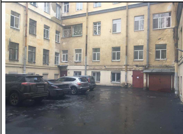
Фото 27. Внутри дворовая территория Объекта оценки
