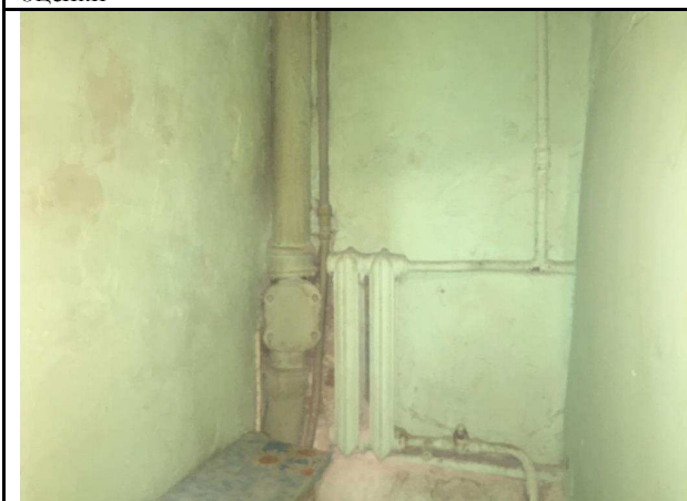
Фото 29. Типичное состояние Объекта оценки
