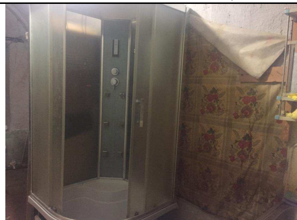
Фото 28. Типичное состояние Объекта оценки
