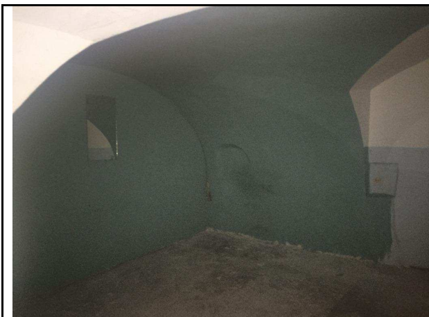
Фото 17. Типичное состояние Объекта оценки
