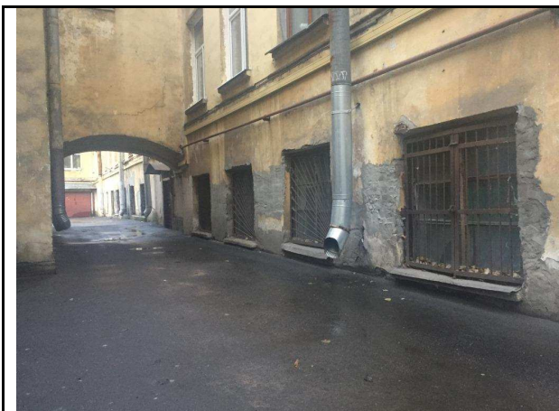
Фото 9. Внутри дворовая территория Объекта оценки
