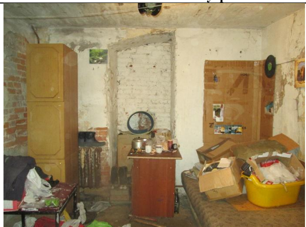
Фото 9. Внутреннее состояние Объекта оценки
