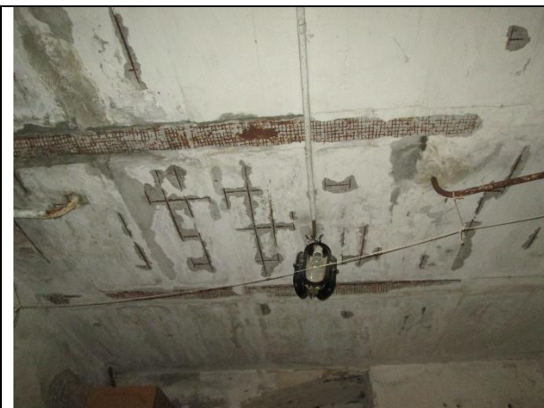
Фото 13. Внутреннее состояние Объекта оценки
