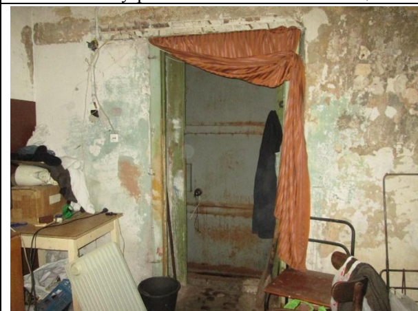
Фото 15. Внутреннее состояние Объекта оценки
