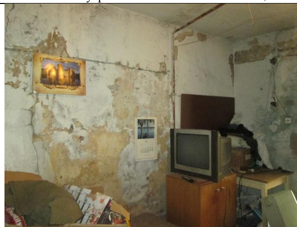
Фото 12. Внутреннее состояние Объекта оценки
