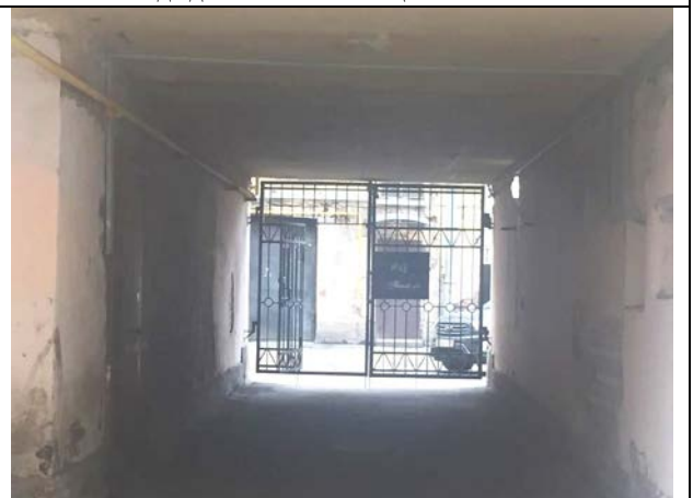
Фото 14. Вход на дворовую территорию здания Объекта оценки
