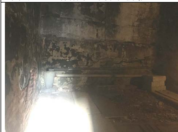
Фото19. Типичное состояние Объекта оценки
