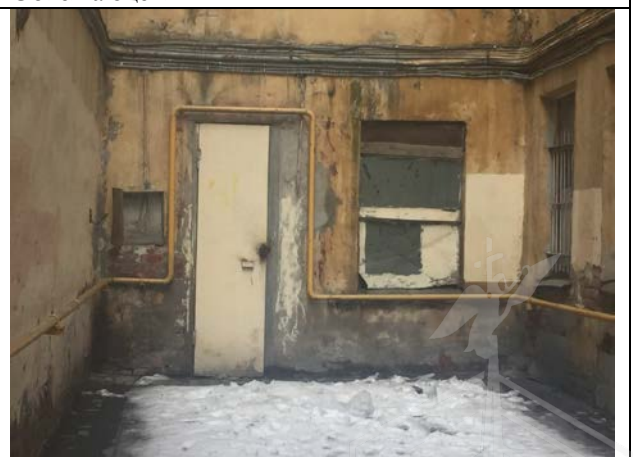
Фото 16. Вход в Объект оценки
