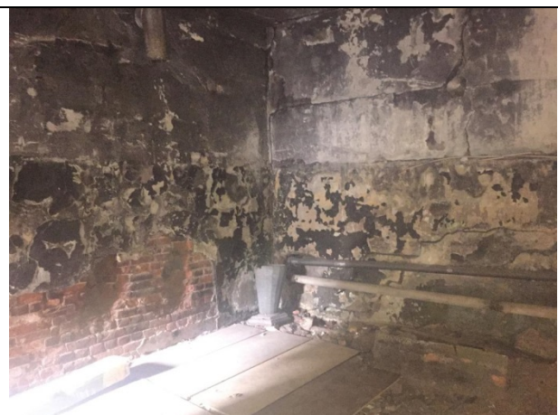
Фото 18. Типичное состояние Объекта оценки
