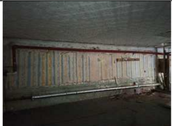
Фото № 12 - Внутренне состояние
