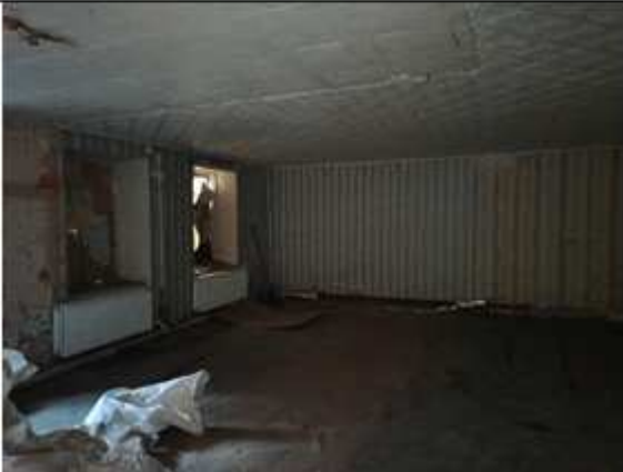
Фото № 9 - Внутренне состояние
