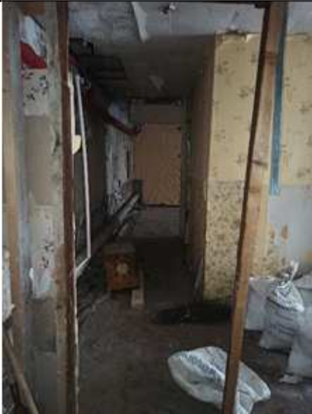
Фото № 13 - Внутренне состояние
