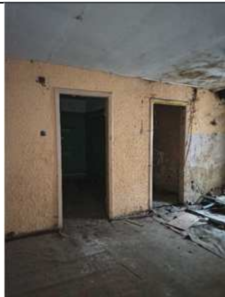
Фото № 16 - Внутренне состояние
