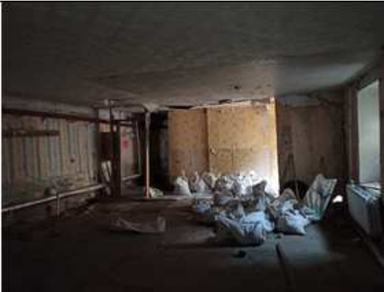
Фото № 11 - Внутренне состояние
