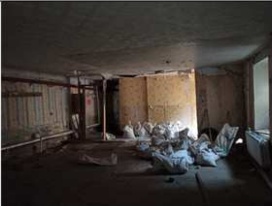
Фото № 11 - Внутренне состояние
