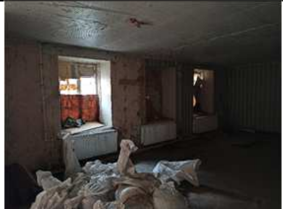
Фото № 10 - Внутренне состояние
