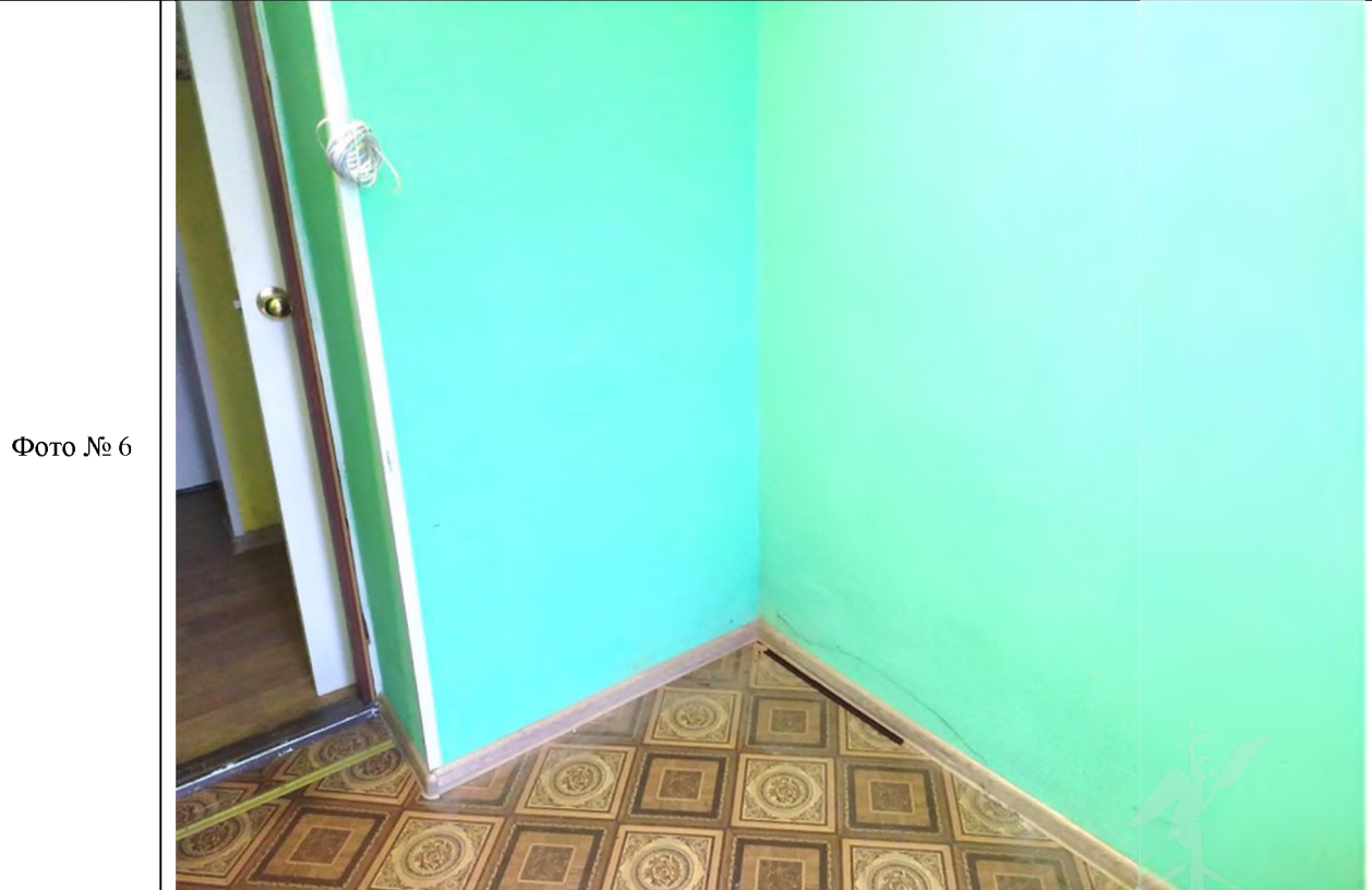
Описание: В ч.п. 13 Объекта демонтировано сантехническое оборудование (раковина)
