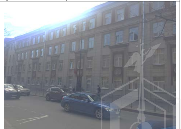
Фото 8. Ближайшее окружение Объекта Оценки (улица Маяковского)
