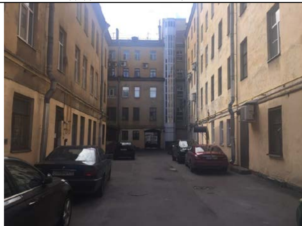
Фото 13. Внутри дворовая территория Объекта оценки
