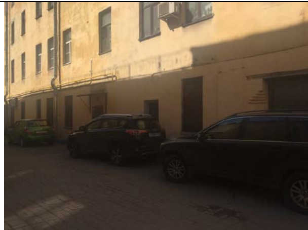
Фото 15. Внутри дворовая территория Объекта оценки
