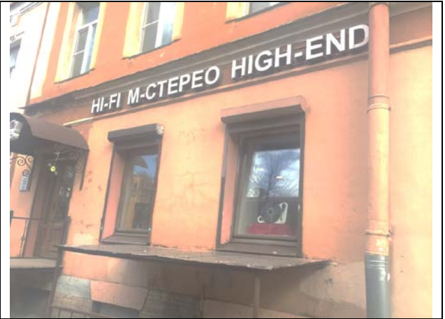
Фото 2. Ближайшее окружение Объекта Оценки (улица Маяковского)
