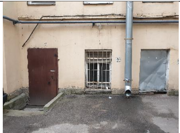
Фото №28. Вход в помещение со двора
