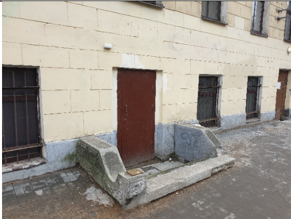
Фото №39. Вход в помещение с улицы
