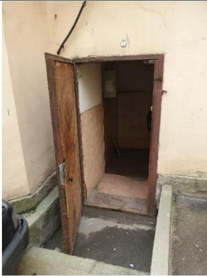
Фото №2. Вход в помещение со двора
