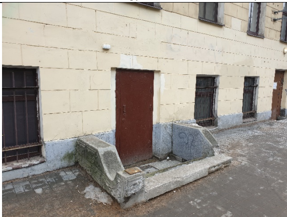
Фото №39. Вход в помещение с улицы
