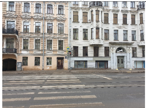
Фото №44. Внешнее окружение объекта.
