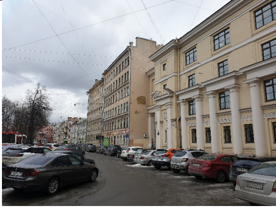
Фото №33. Внешнее окружение объекта
