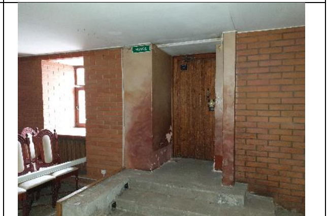
Фото №22. Выход на улицу Садовая
