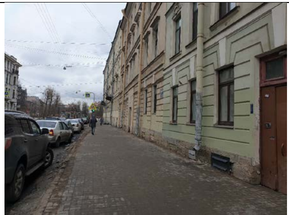
Фото №42. Внешнее окружение объекта.
