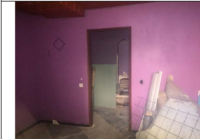
Фото 25. Типичное состояние Объекта оценки
