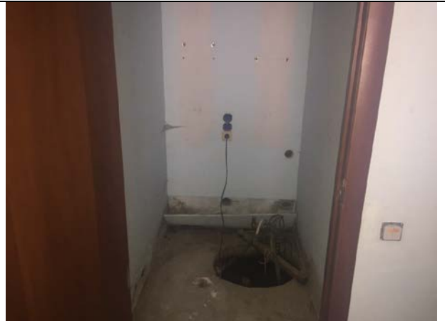
Фото 32. Типичное состояние Объекта оценки
