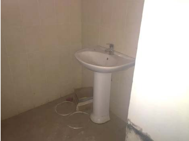
Фото 29. Типичное состояние Объекта оценки
