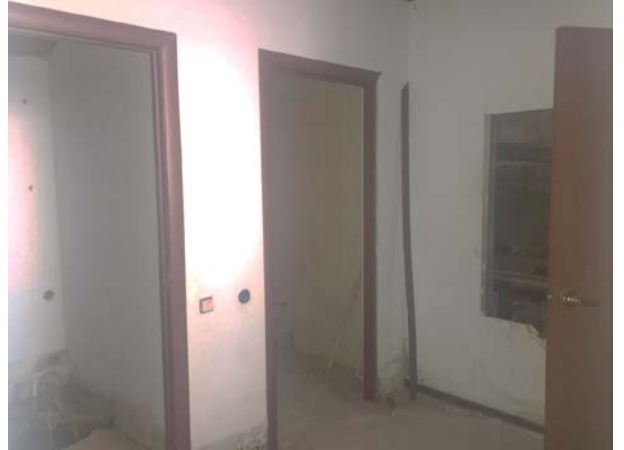
Фото 30. Типичное состояние Объекта оценки
