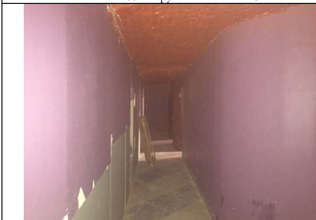
Фото 17. Типичное состояние Объекта оценки
