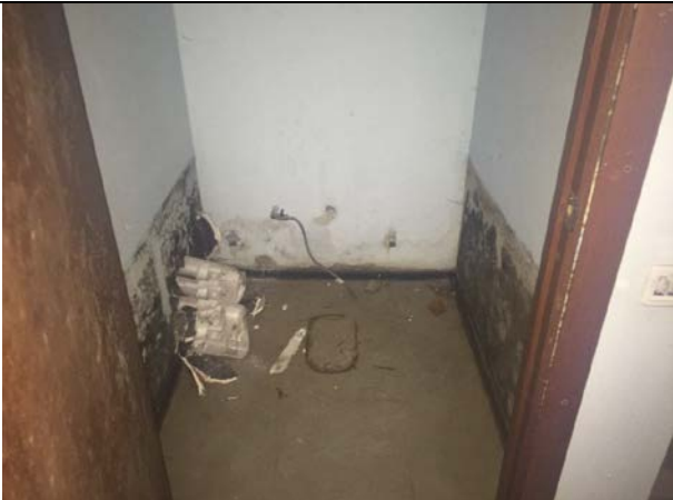
Фото 31. Типичное состояние Объекта оценки
