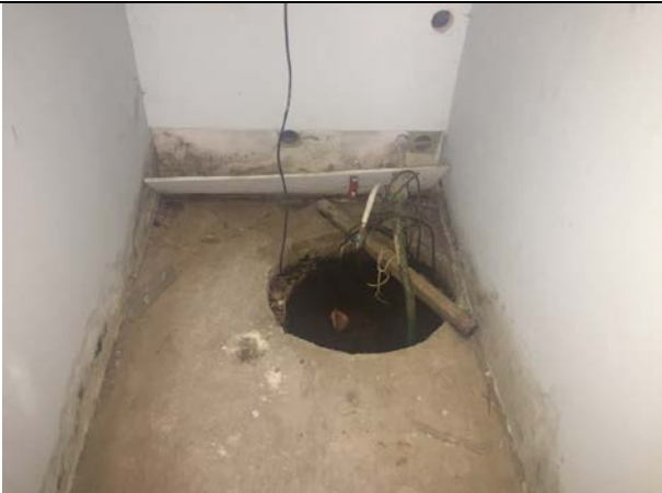
Фото 33. Типичное состояние Объекта оценки
