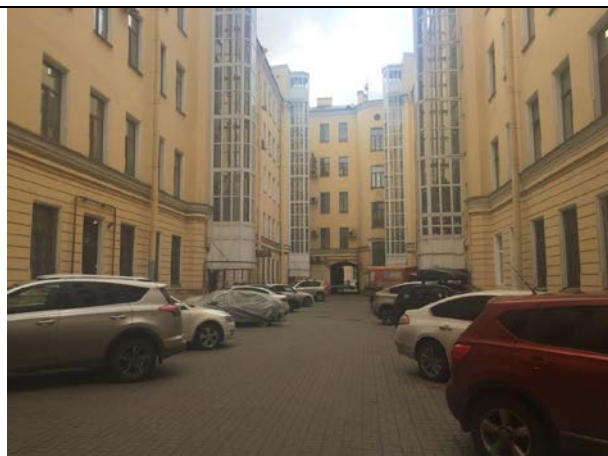
Фото 10. Внутри дворовая территория Объекта оценки
