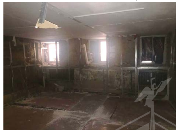
Фото 20. Типичное состояние Объекта оценки
