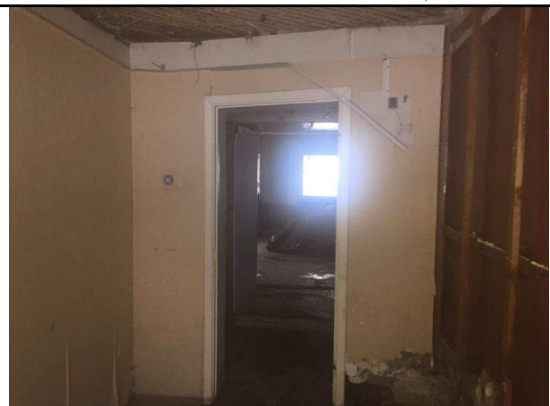
Фото 20. Типичное состояние Объекта оценки
