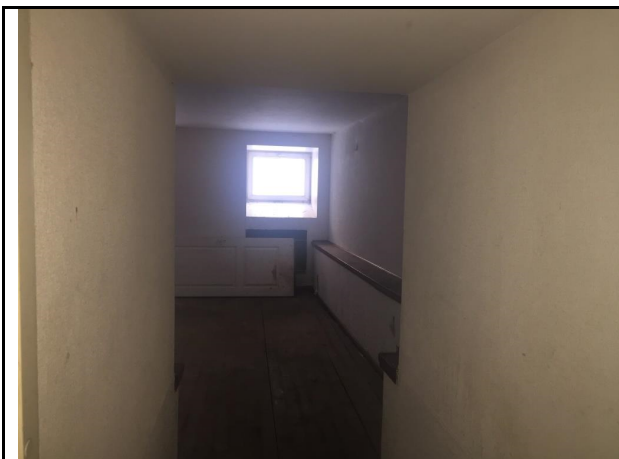
Фото 25. Типичное состояние Объекта оценки
