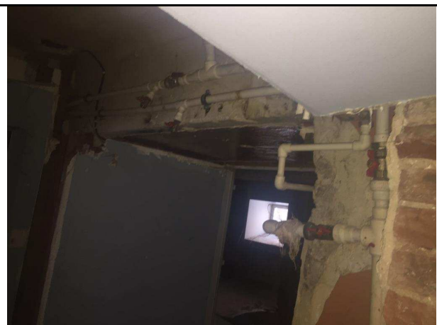
Фото 18. Типичное состояние Объекта оценки
