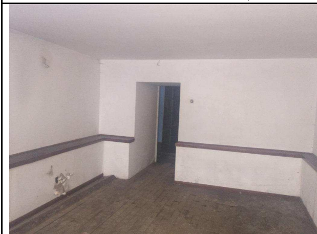
Фото 27. Типичное состояние Объекта оценки
