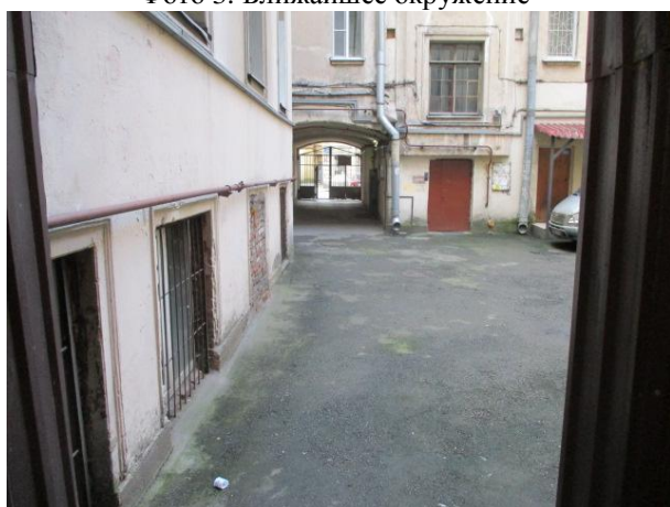
Фото 5. Дворовая территория и оконные проемы Объекта оценки
