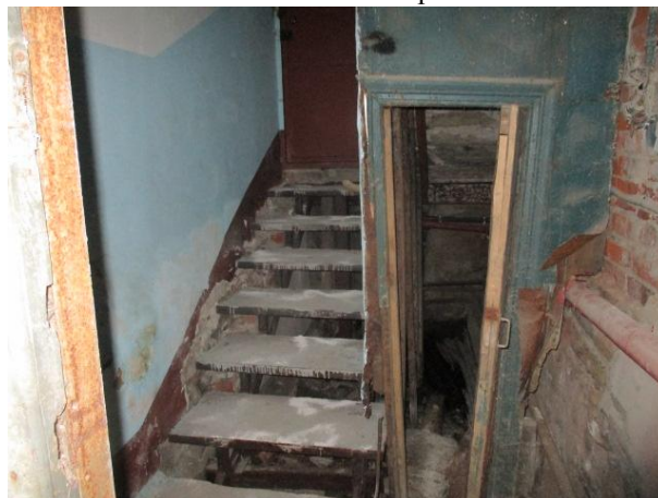
Фото 12. Общий вход в помещение
