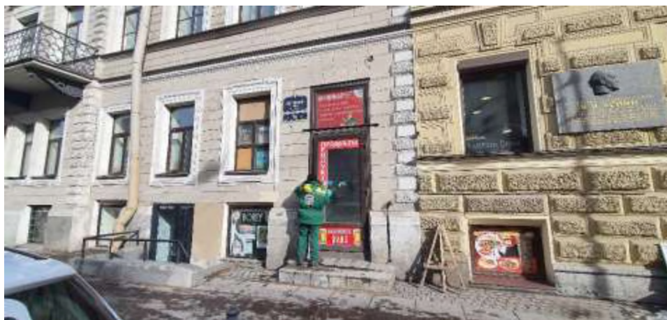
Фото 1. Вход в помещение. Здание расположения.
