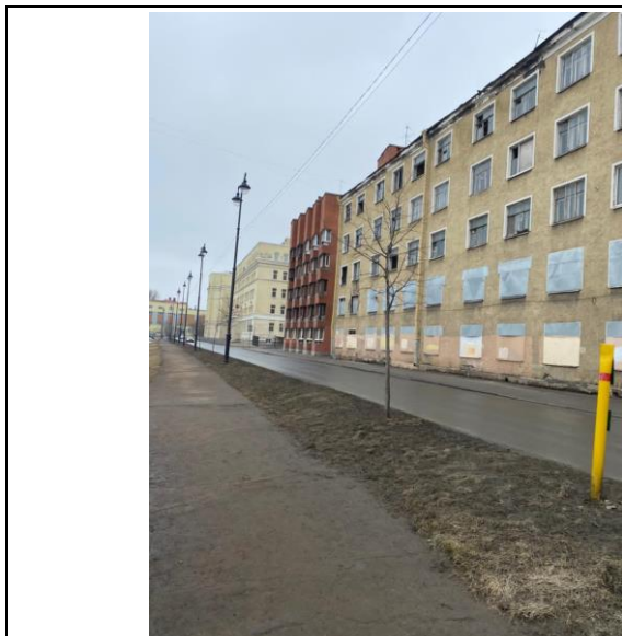
Фото 1. Вид на здание размещения Объекта оценки с наб. р. Пряжки.
