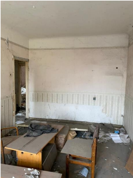
Фото 23.Состояние помещений Объекта оценки.
