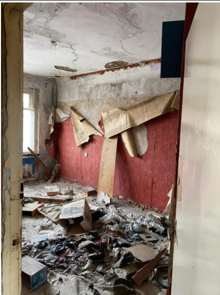
Фото 25.Состояние помещений Объекта оценки.
