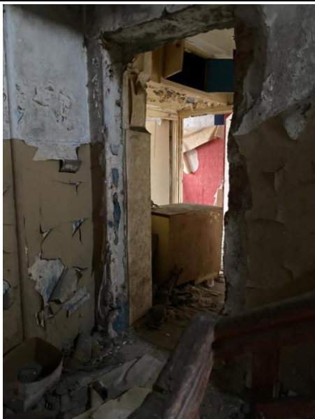
Фото 17.Состояние помещений Объекта оценки.
