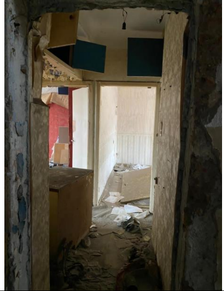
Фото 18. Состояние помещений Объекта оценки.
