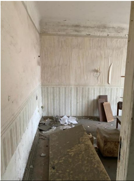
Фото 21.Состояние помещений Объекта оценки.
