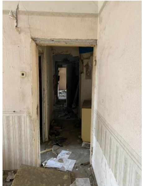
Фото 24.Состояние помещений Объекта оценки.
