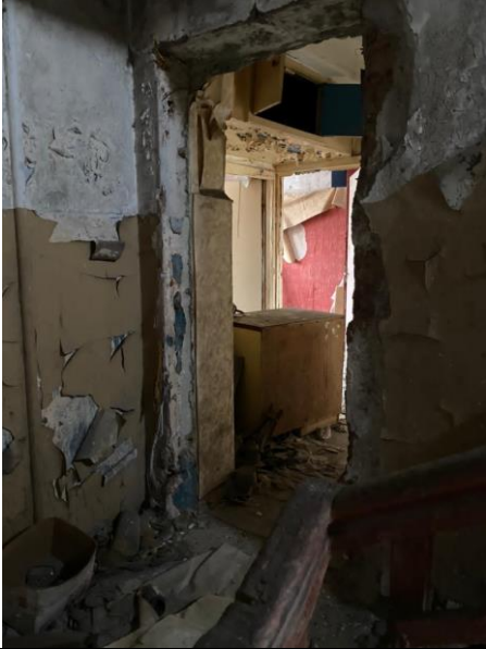
Фото 17. Состояние помещений Объекта оценки.
