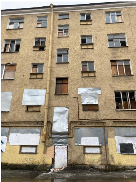
Фото 9. Вход в подъезд.
