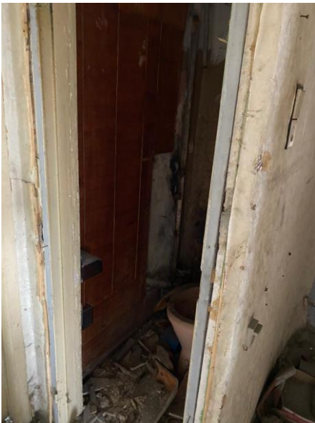
Фото 19. Состояние помещений Объекта оценки.
