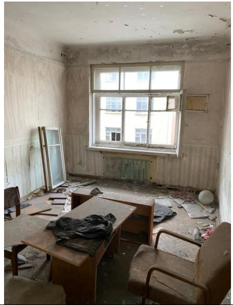
Фото 22.Состояние помещений Объекта оценки.
