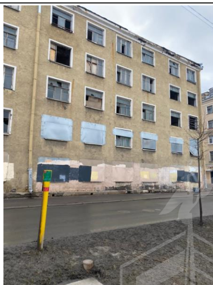
Фото 2. Вид на здание размещения Объекта оценки с наб. р. Пряжки.
