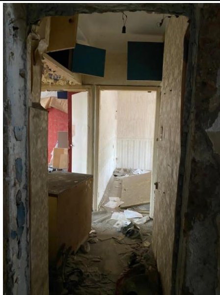
Фото 18.Состояние помещений Объекта оценки.
