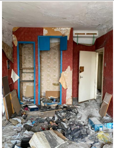
Фото 26.Состояние помещений Объекта оценки.
