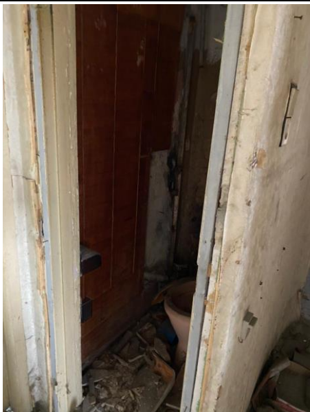
Фото 19.Состояние помещений Объекта оценки.
