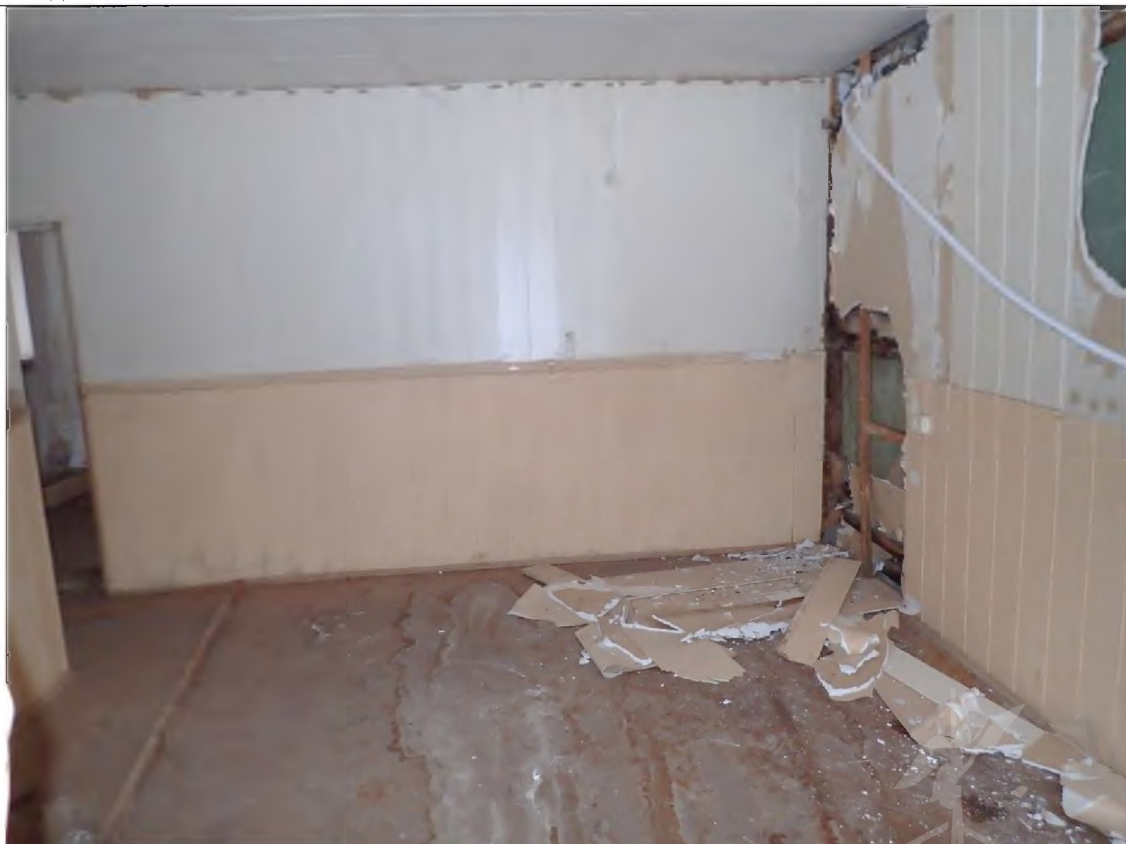
Описание: Вид внутри Объекта (ч.п. 3)
