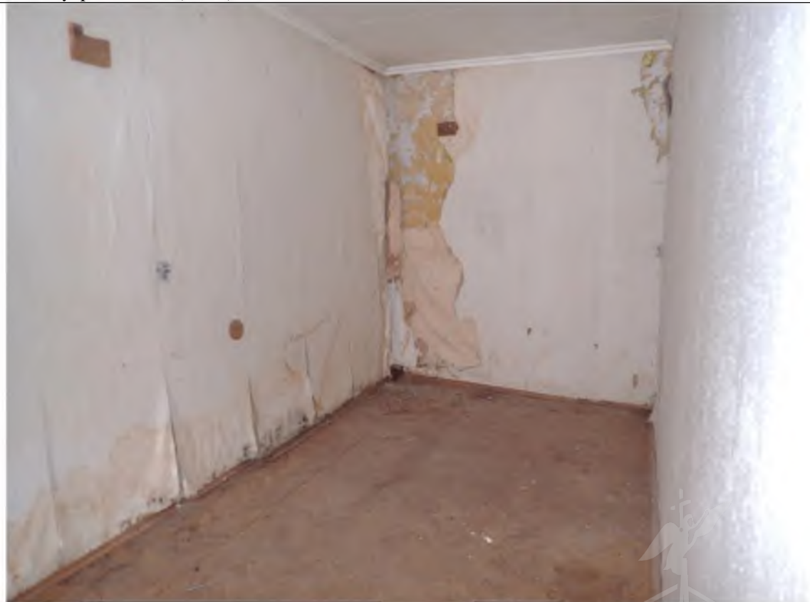
Описание: Вид внутри Объекта (ч.п. 4)
