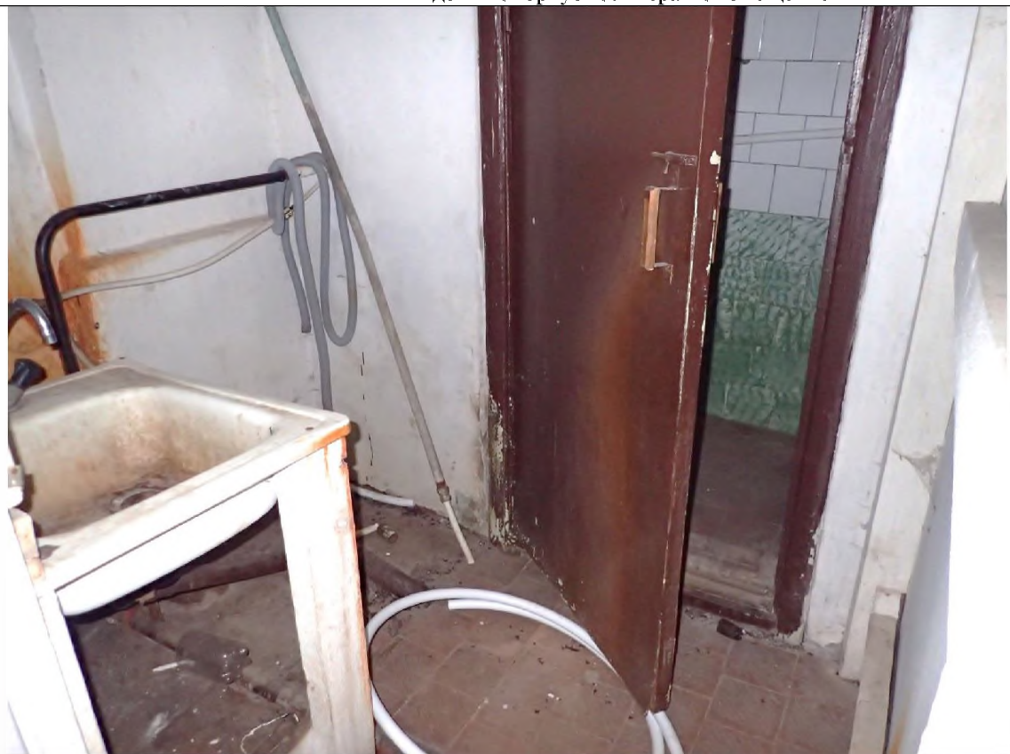
Описание: Вид внутри Объекта (ч.п. 8)
