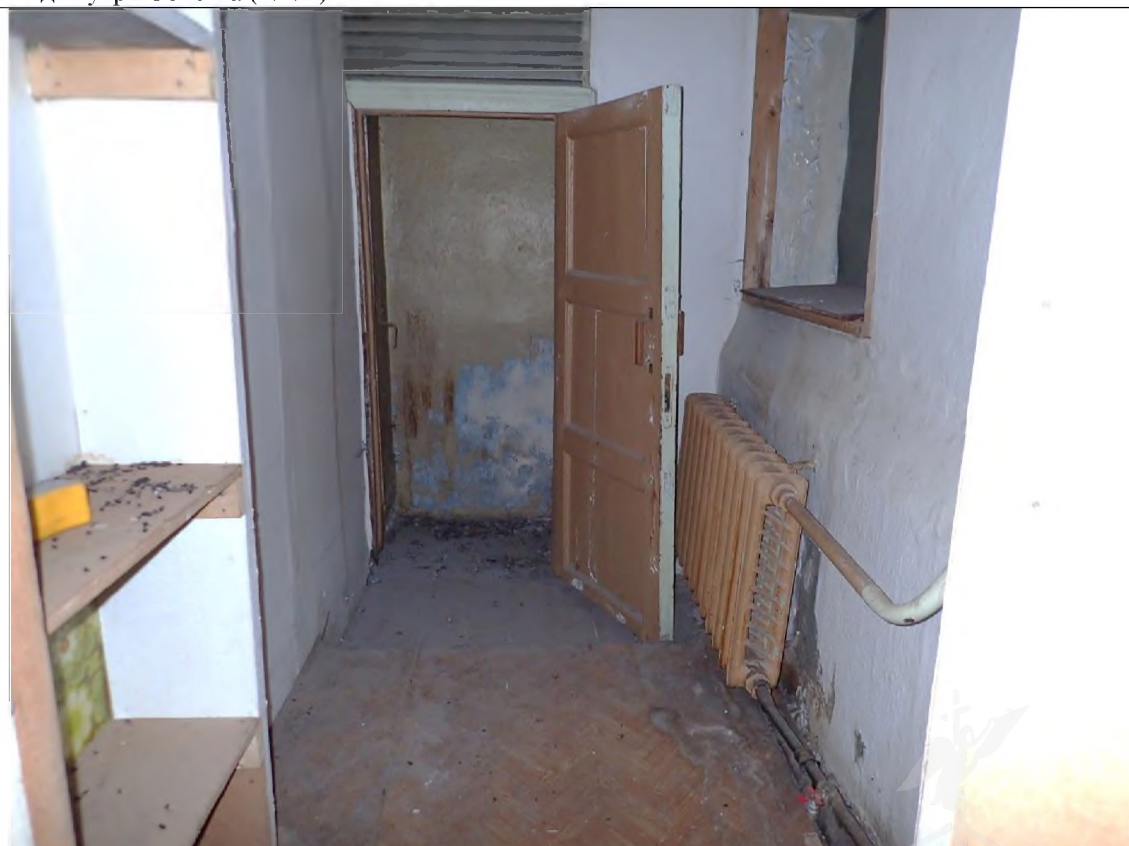
Описание: Вид внутри Объекта (ч.п. 6, 5)
