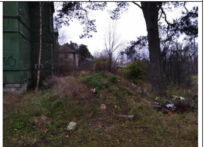
Фото 4. Вид на здание размещения Объекта оценки.
