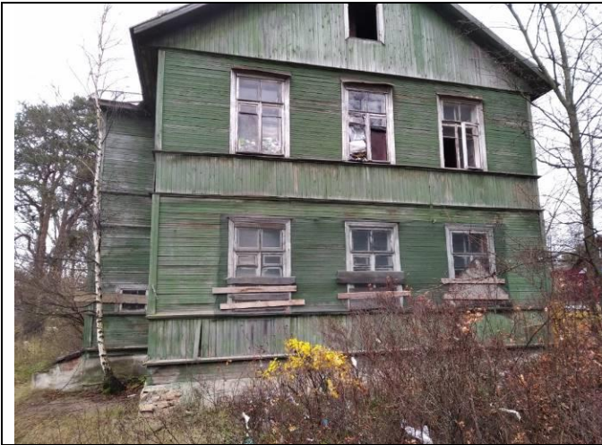
Фото 7. Вид на здание размещения Объекта оценки.
