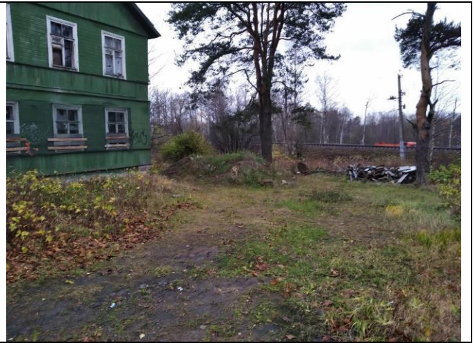
Фото 2. Вид на здание размещения Объекта оценки.
