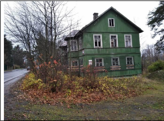
Фото 1. Вид на здание размещения Объекта оценки.
