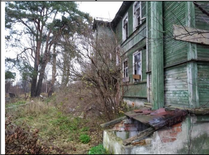
Фото 9. Вид на здание размещения Объекта оценки.
