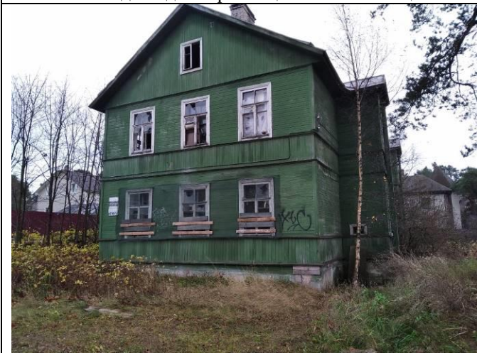
Фото 3. Вид на здание размещения Объекта оценки.
