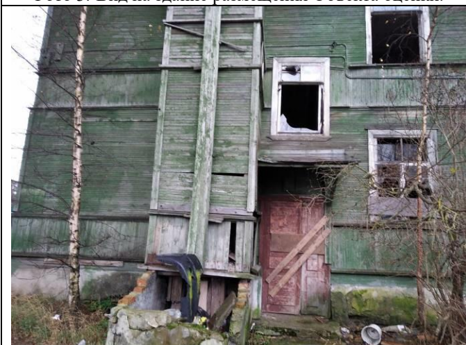
Фото 5. Вид на здание размещения Объекта оценки.
