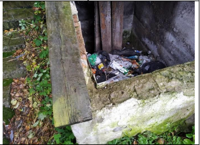
Фото 10. Вид на здание размещения Объекта оценки.
