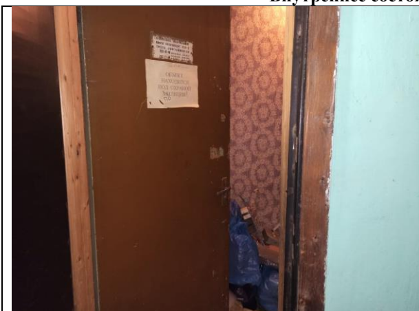
Фото 11. Внутреннее состояние Объекта оценки
