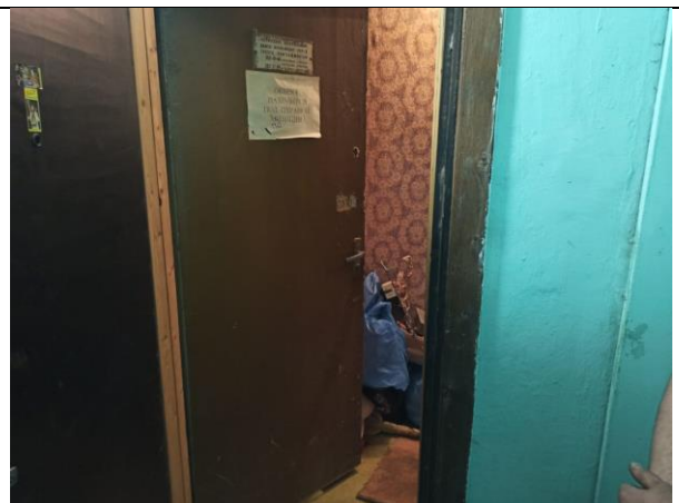
Фото 24. Внутреннее состояние Объекта оценки
