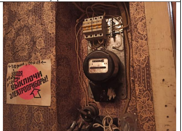
Фото 26. Внутреннее состояние Объекта оценки
