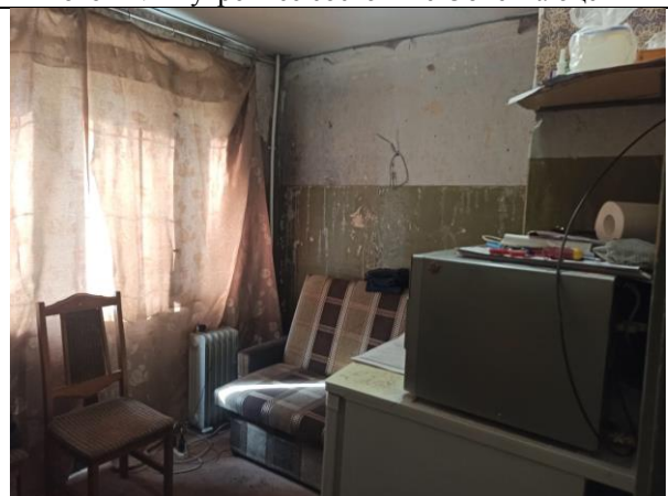
Фото 14. Внутреннее состояние Объекта оценки
