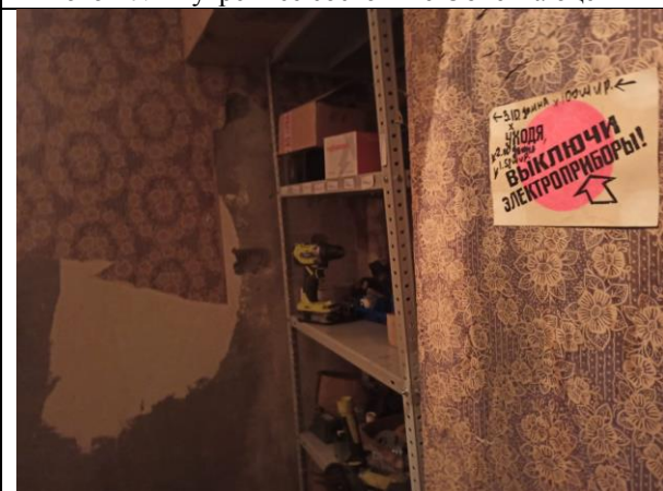
Фото 29. Внутреннее состояние Объекта оценки
