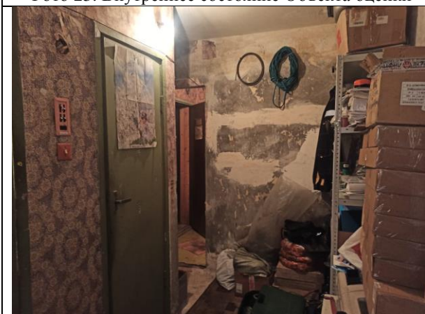
Фото 25. Внутреннее состояние Объекта оценки
