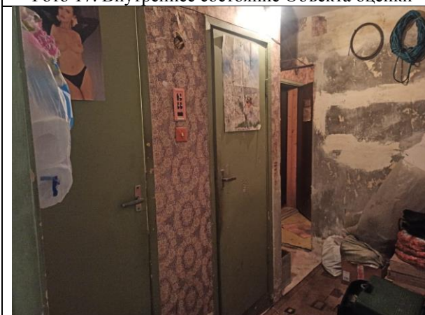
Фото 19. Внутреннее состояние Объекта оценки
