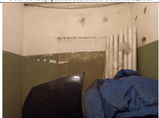
Фото 18. Внутреннее состояние Объекта оценки
