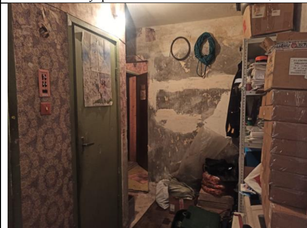
Фото 25. Внутреннее состояние Объекта оценки
