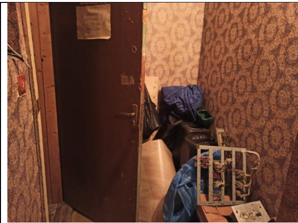
Фото 23. Внутреннее состояние Объекта оценки
