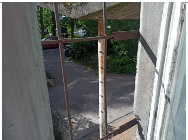
Фото 16. Внутреннее состояние Объекта оценки
