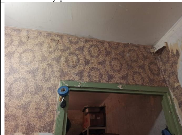
Фото 27. Внутреннее состояние Объекта оценки
