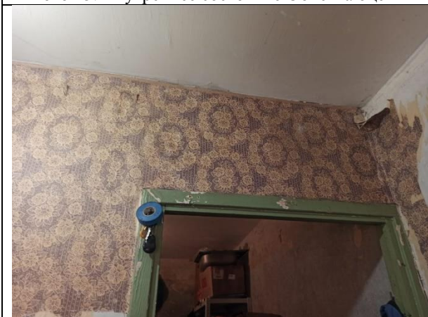
Фото 27. Внутреннее состояние Объекта оценки
