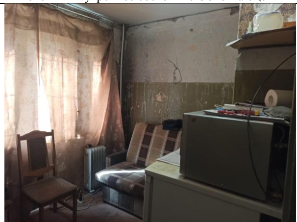
Фото 14. Внутреннее состояние Объекта оценки
