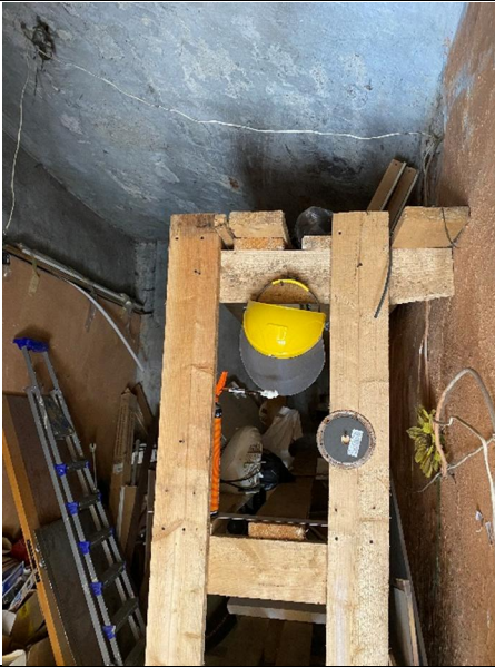
Фото 13. Внутреннее состояние Объекта оценки
