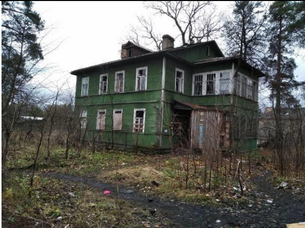
Фото 1. Вид на здание размещения Объекта оценки.
