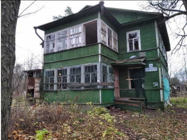
Фото 3. Вид на здание размещения Объекта оценки.
