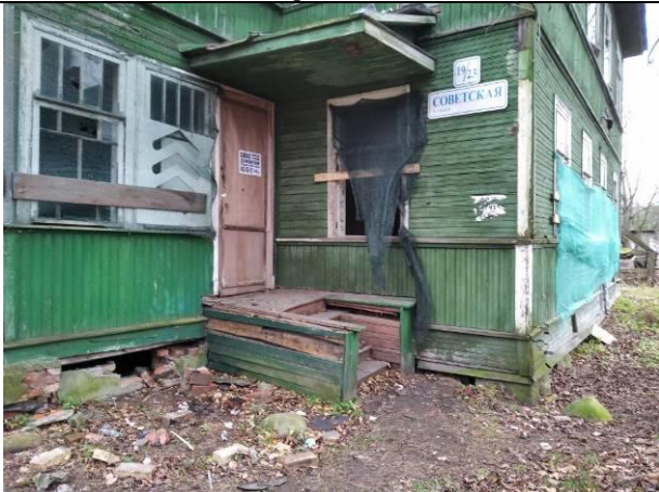
Фото 5. Вид на здание размещения Объекта оценки.
