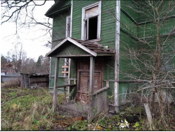
Фото 7. Вид на здание размещения Объекта оценки.
