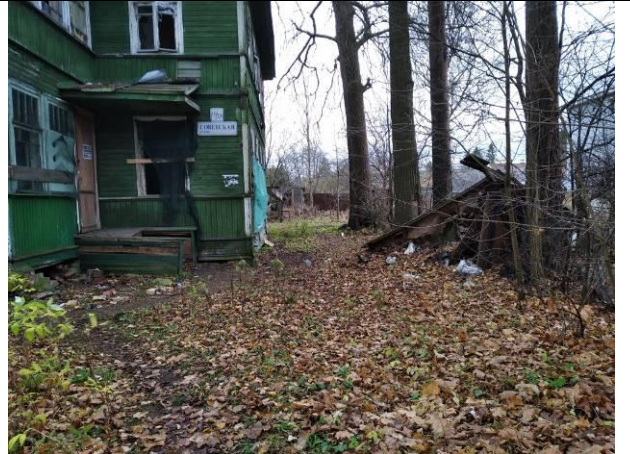
Фото 4. Вид на здание размещения Объекта оценки.
