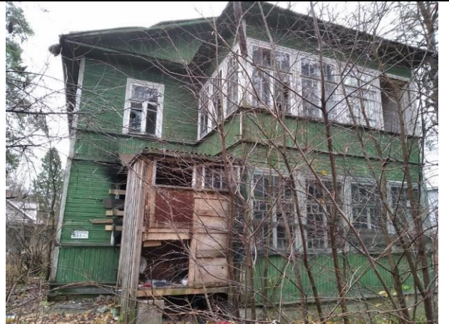
Фото 2. Вид на здание размещения Объекта оценки.
