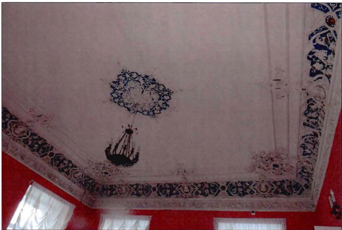
10. Интерьер. Фрагмент. Пом. 12-Н (16).
