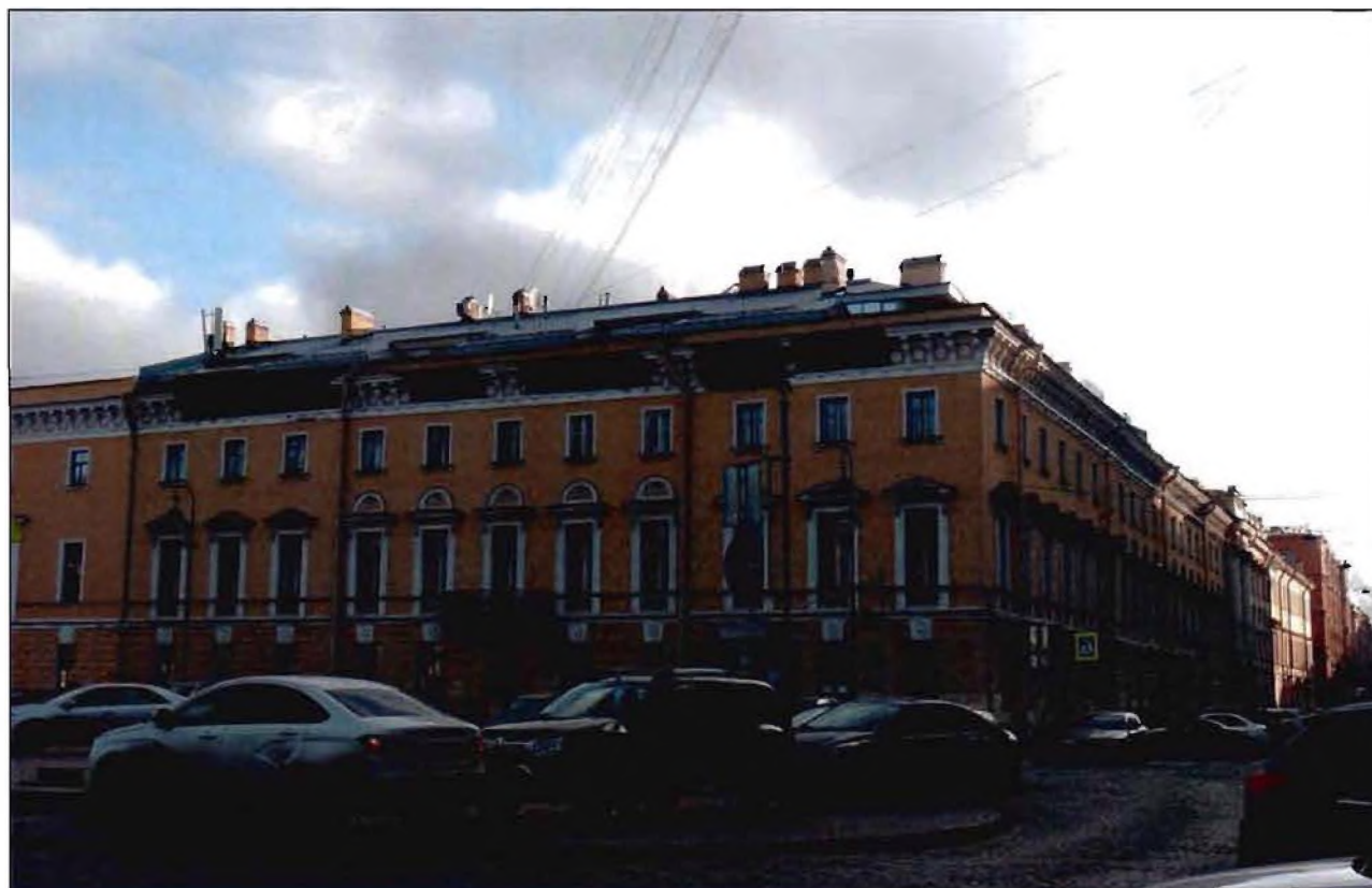
1. Общий вид с юго-востока.
