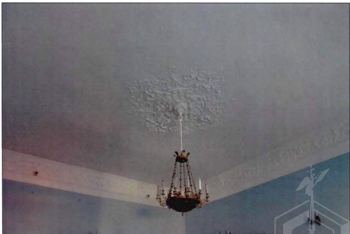
11. Интерьер. Фрагмент. Пом. 12-Н (3).
