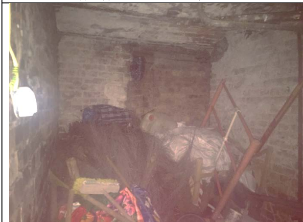
Фото 13. Типичное состояние Объекта оценки
