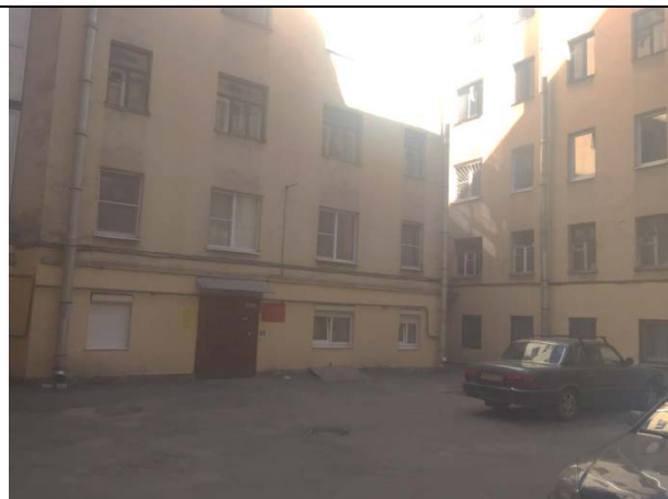
Фото 8. Внутри дворовая территория Объекта оценки
