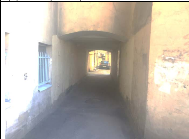
Фото 9. Внутри дворовая территория Объекта оценки
