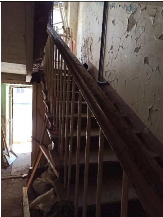
Фото № 3 – Внутреннее состояние
