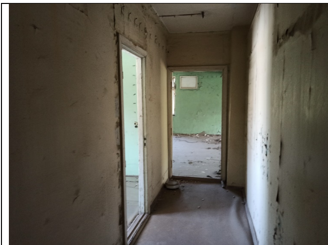
Фото № 11 - Внутреннее состояние
