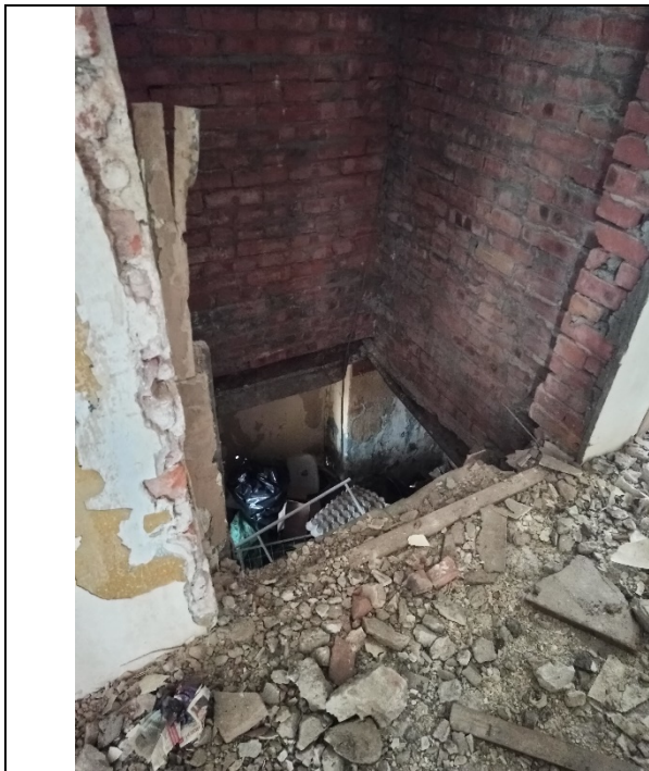
Фото № 23 - Внутреннее состояние
