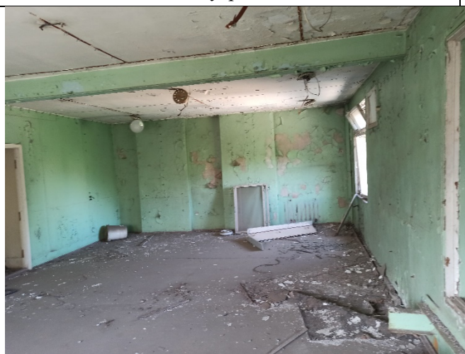
Фото № 9 - Внутренне состояние
