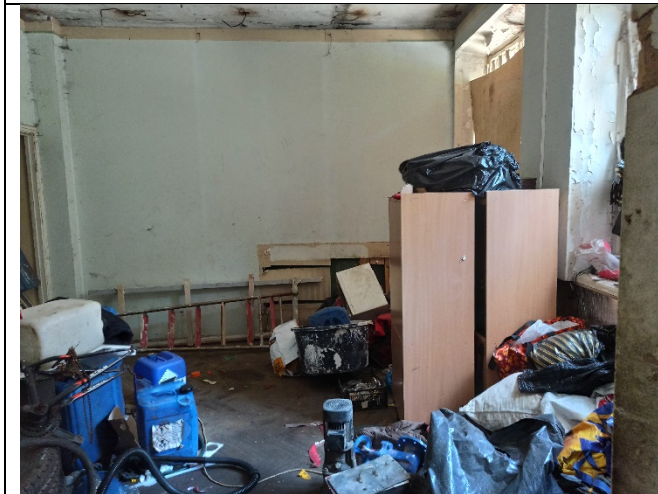
Фото № 25 - Внутреннее состояние
