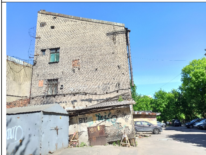
Фото № 27 - Фасад здания
