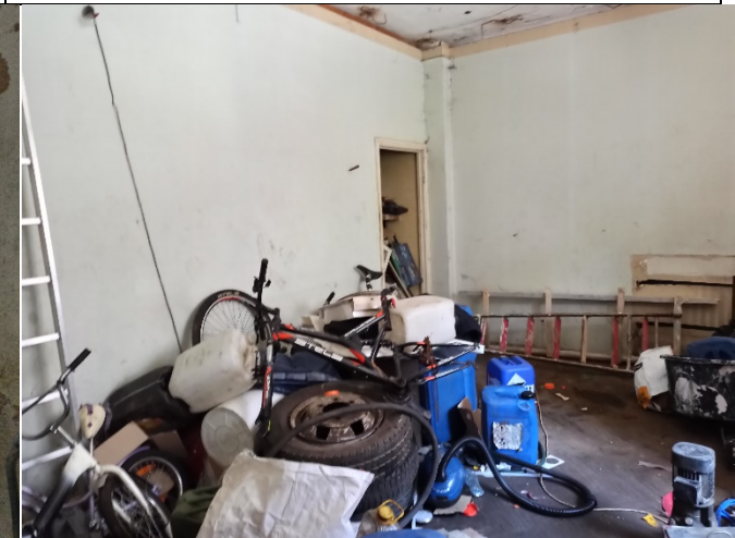
Фото № 26 - Внутреннее состояние
