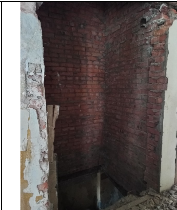
Фото № 24 - Внутреннее состояние
