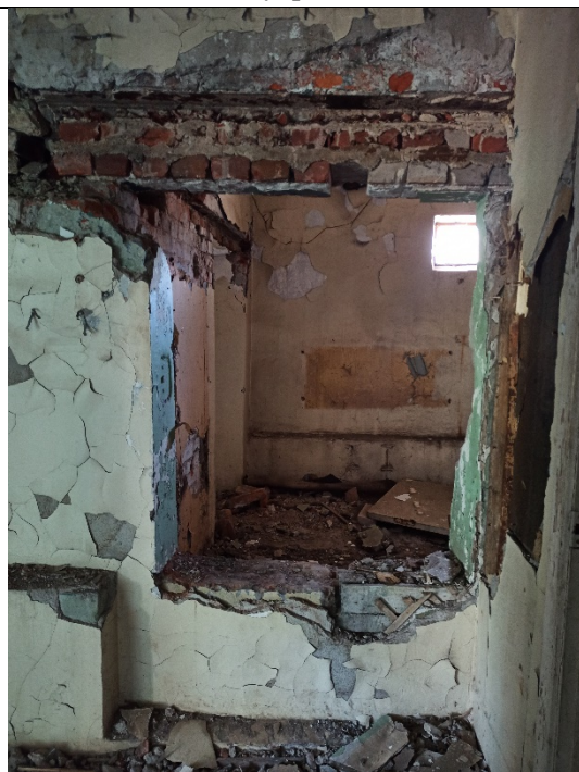
Фото № 7 - Внутренне состояние
