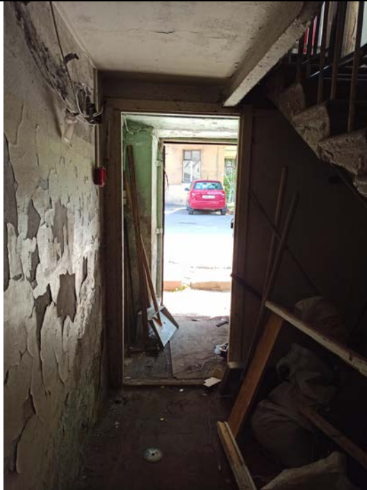
Фото № 2 – Внутреннее состояние
