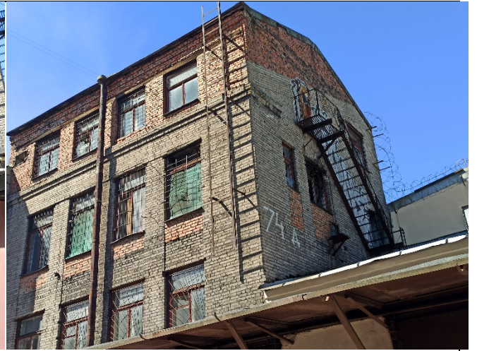
Фото № 30 – Фасад здания
