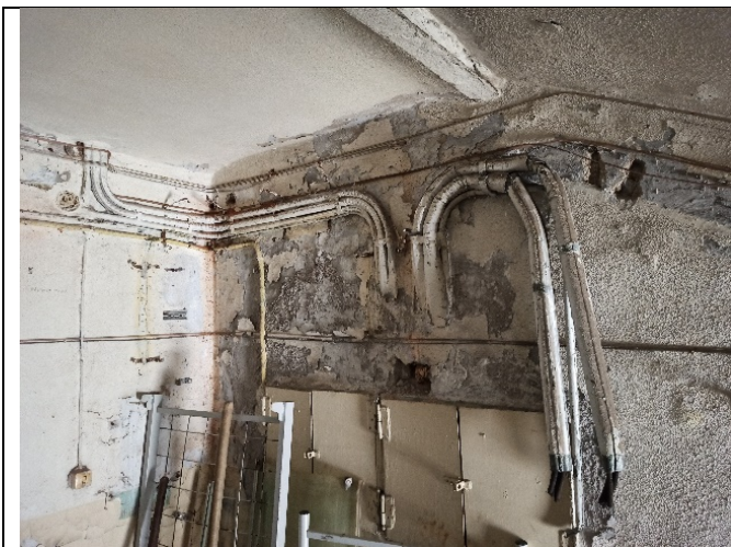
Фото № 5 – Внутреннее состояние
