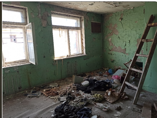
Фото № 12 - Внутреннее состояние
