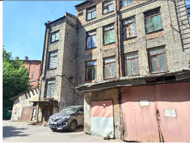
Фото № 29 - Фасад здания
