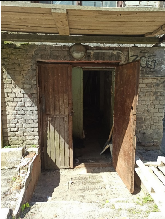
Фото № 1 – Вход в помещение
