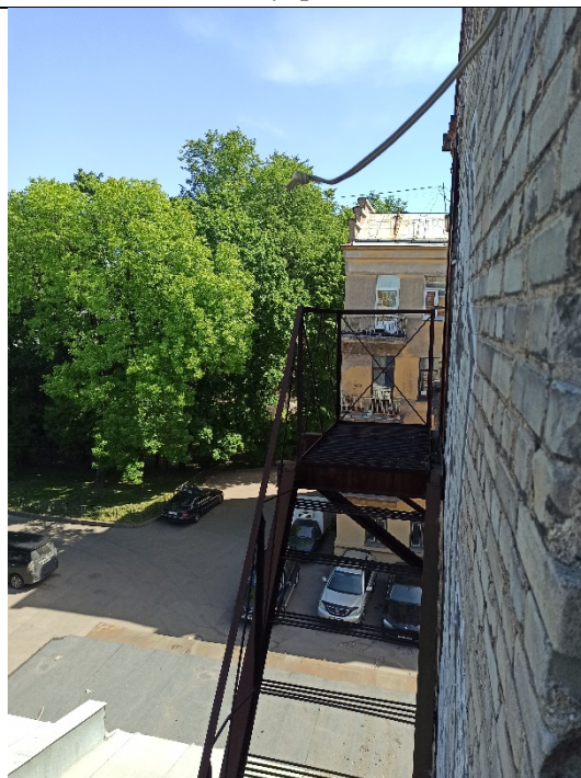
Фото № 8 - Внутренне состояние
