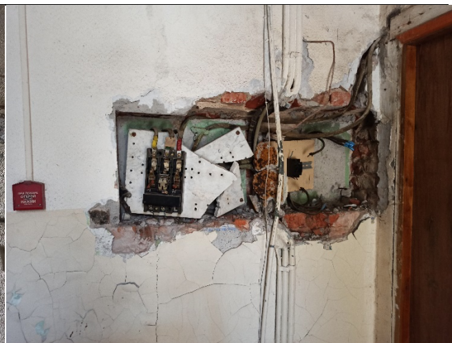
Фото № 6 - Внутренне состояние
