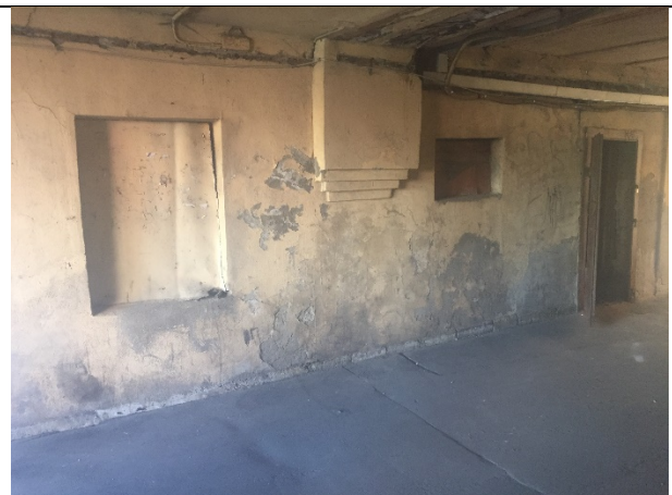
Фото 16. Вход в помещения Объекта оценки
