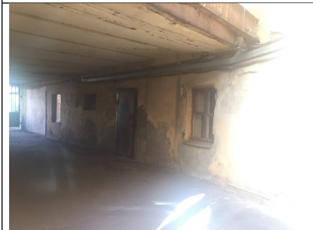
Фото 15. Вход в помещения Объекта оценки
