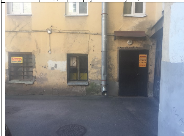
Фото 9. Внутри дворовая территория Объекта оценки
