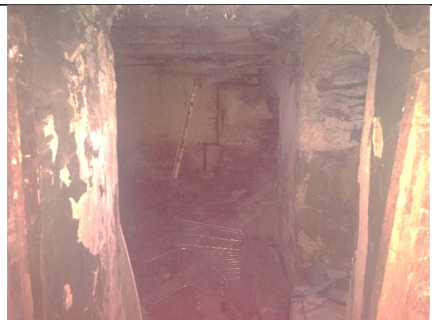
Фото 28. Типичное состояние Объекта оценки
