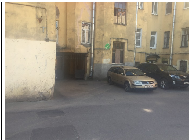
Фото 11. Внутри дворовая территория Объекта оценки
