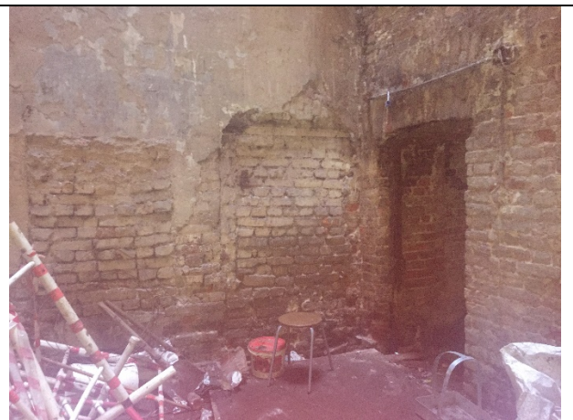
Фото 22. Типичное состояние Объекта оценки
