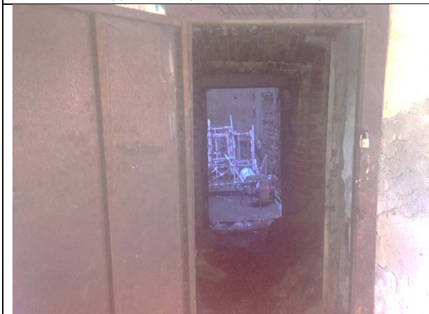
Фото 17. Вход в помещения Объекта оценки
