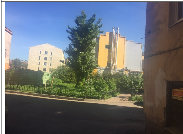
Фото 13. Внутри дворовая территория Объекта оценки
