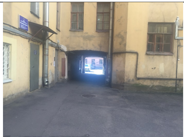
Фото 12. Внутри дворовая территория Объекта оценки
