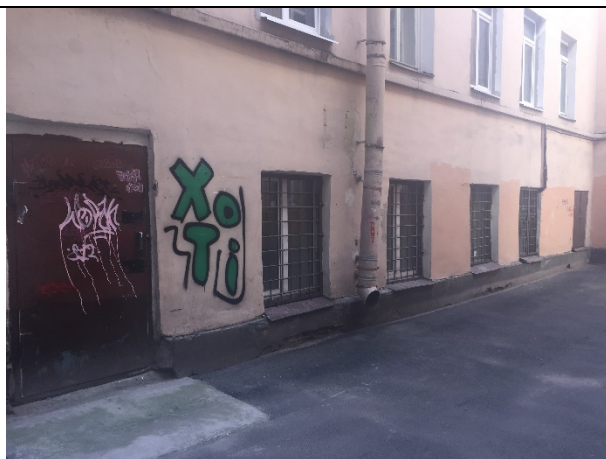
Фото 20. Вход в здание Объекта оценки
