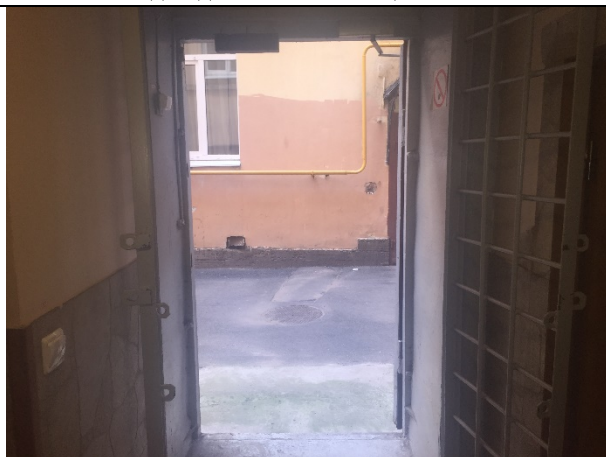
Фото 22. Вход в здание Объекта оценки
