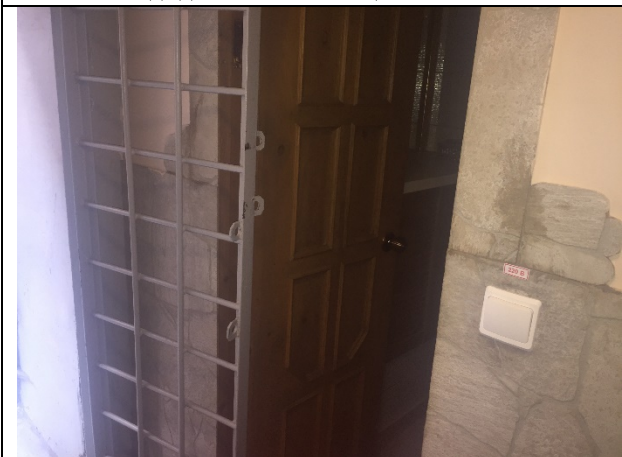
Фото 21. Вход в здание Объекта оценки
