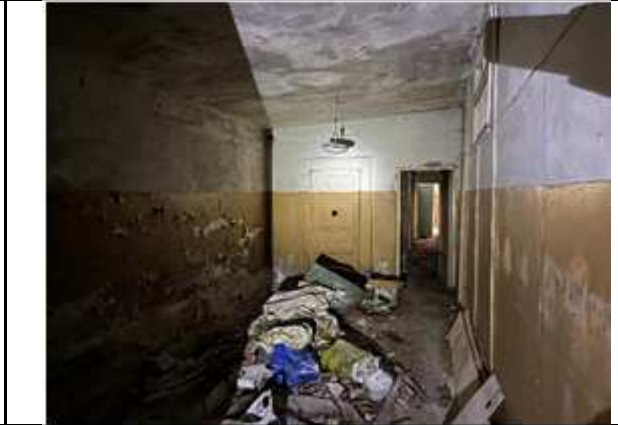
Фото №18: Внутреннее состояние
