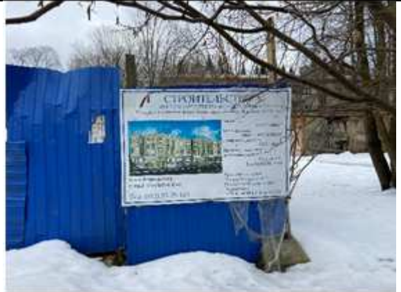
Фото №24: Окружение объекта. Строительная площадка ЖК «Изумрудный»
