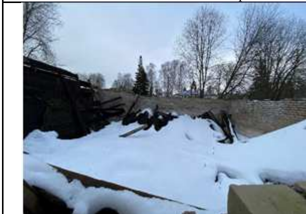
Фото №11: Внешний вид здания. Повреждения
