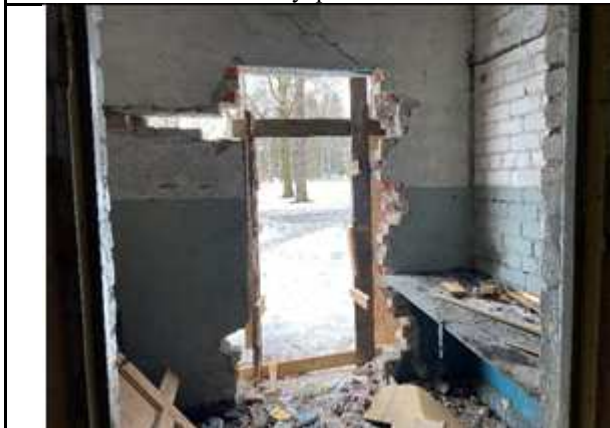
Фото № 19: Внутреннее состояние. Вход
