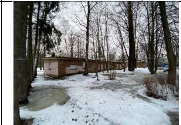
Фото №12: Внешний вид здания. Повреждения
