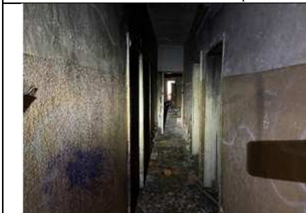
Фото №13: Внутреннее состояние
