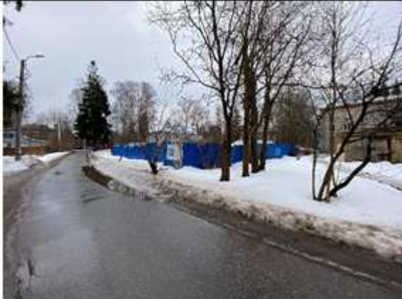
Фото №23: Окружение объекта. Строительная площадка ЖК «Изумрудный»
