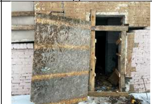
Фото № 20: Внешнее состояние. Вход
