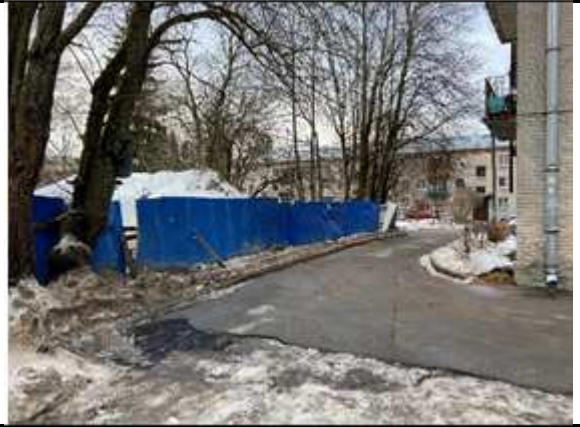
Фото №22: Окружение объекта. Строительная площадка ЖК «Изумрудный»
