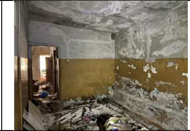
Фото №16: Внутреннее состояние
