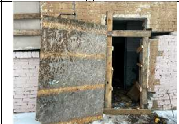
Фото № 20: Внешнее состояние. Вход
