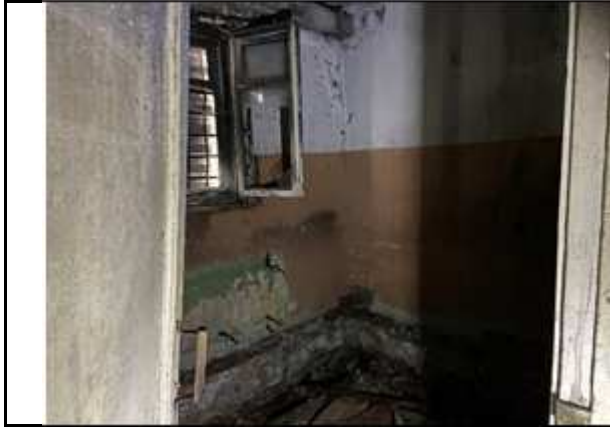
Фото №15: Внутреннее состояние
