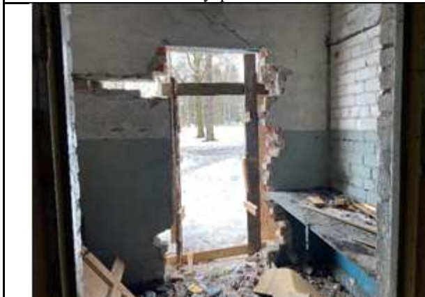
Фото № 19: Внутреннее состояние. Вход
