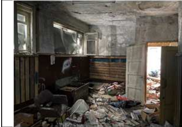
Фото №17 Внутреннее состояние
