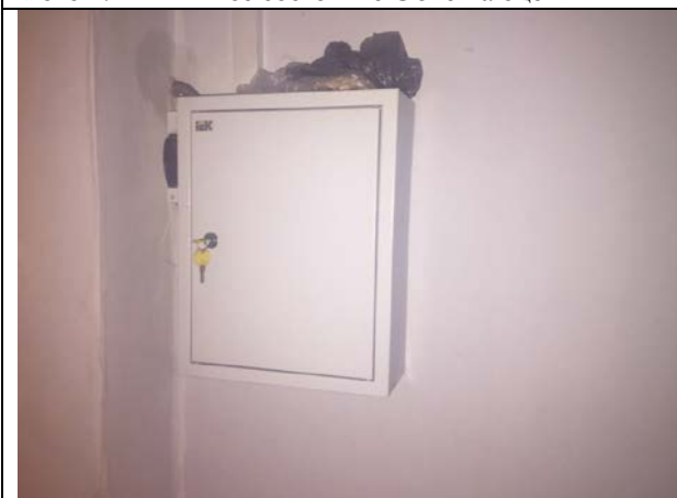
Фото 21. Типичное состояние Объекта оценки
