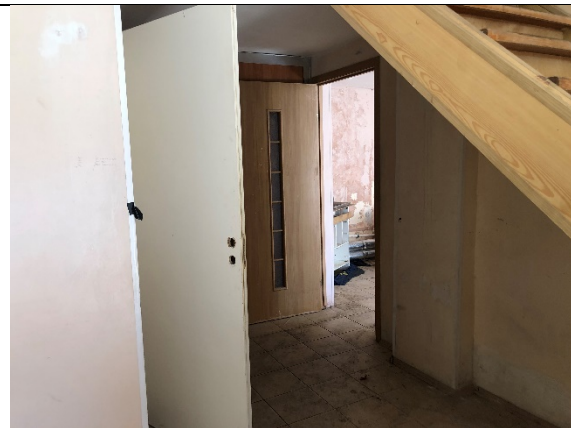
Фото № 12 – Внутреннее состояние
