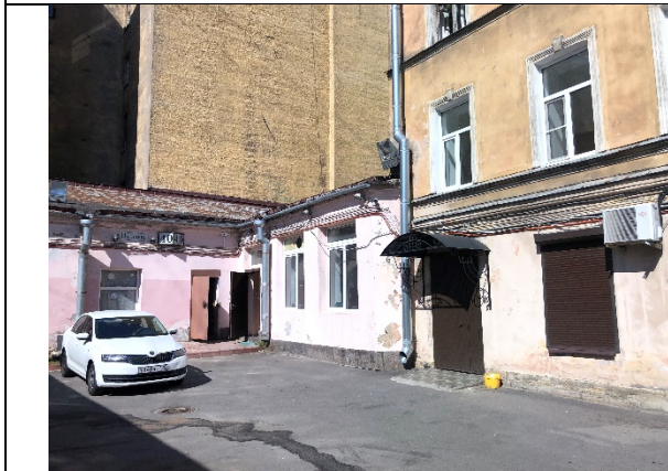
Фото № 21 – Проход к помещению
