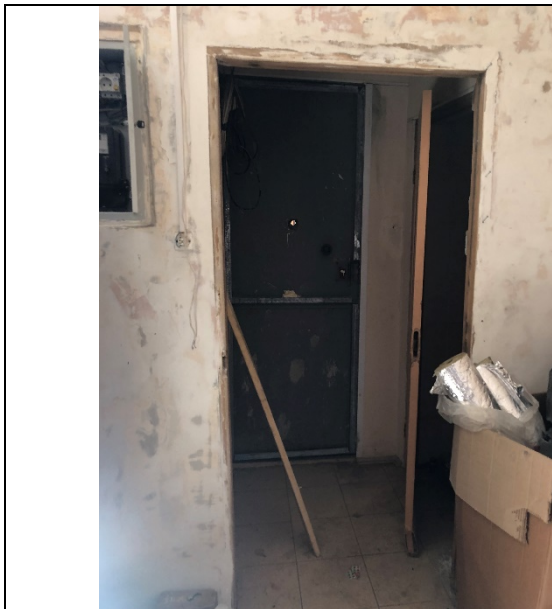
Фото № 5 – Внутреннее состояние
