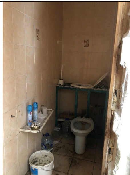
Фото № 6 - Внутренне состояние
