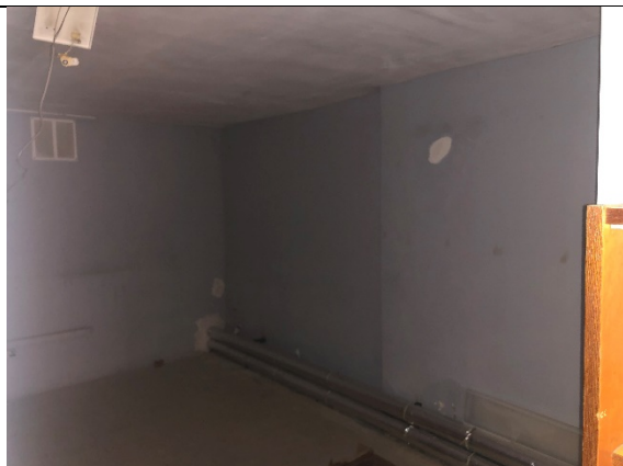
Фото № 17 – Внутреннее состояние
