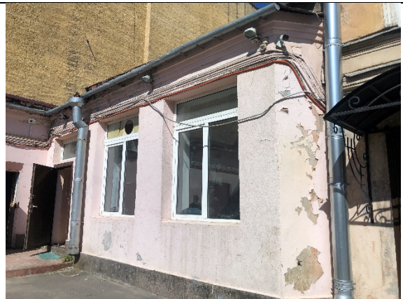
Фото № 22 – Проход к помещению
