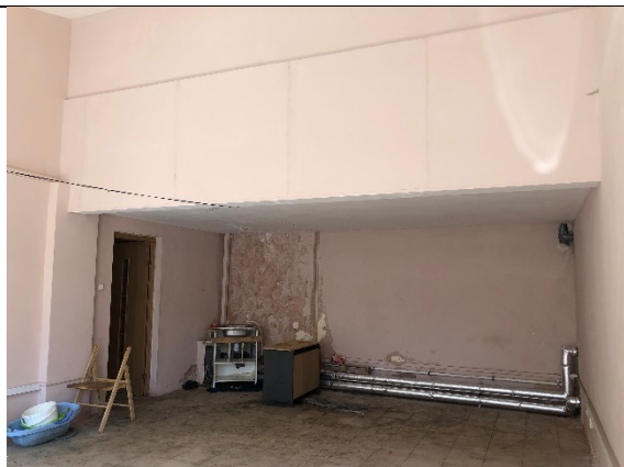
Фото № 15 – Внутреннее состояние
