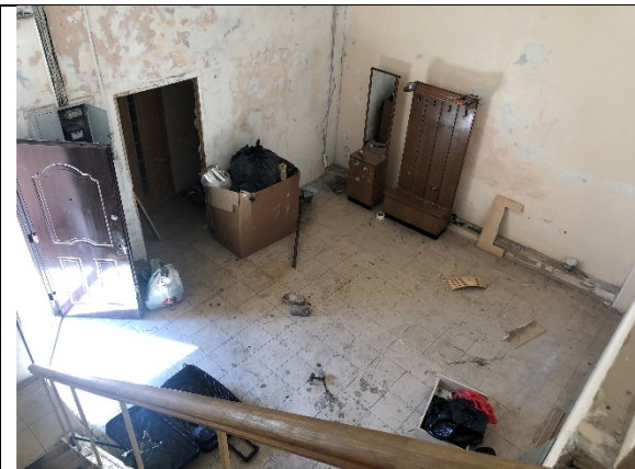
Фото № 11 – Внутреннее состояние
