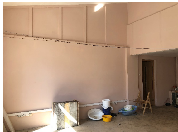
Фото № 16 – Внутреннее состояние
