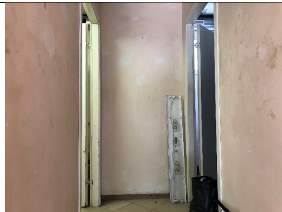
Фото № 8 - Внутренне состояние
