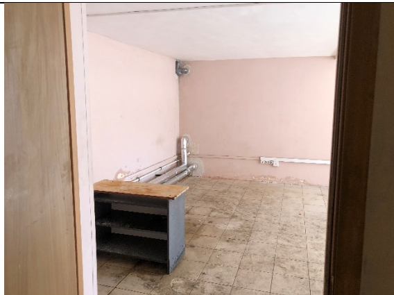
Фото № 13 – Внутреннее состояние
