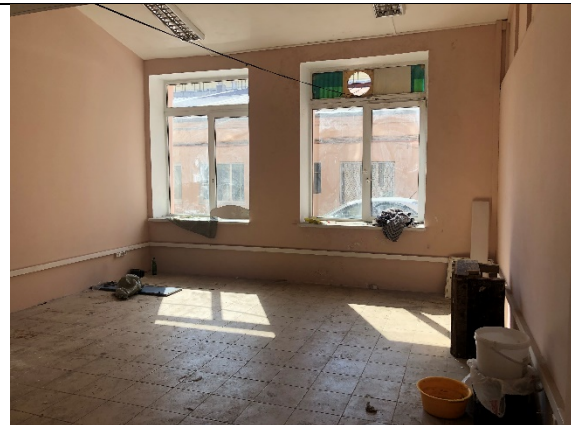
Фото № 14 – Внутреннее состояние
