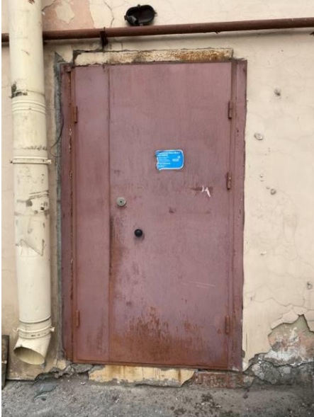
Фото 9. Вход в пом. 1-Н со двора.
