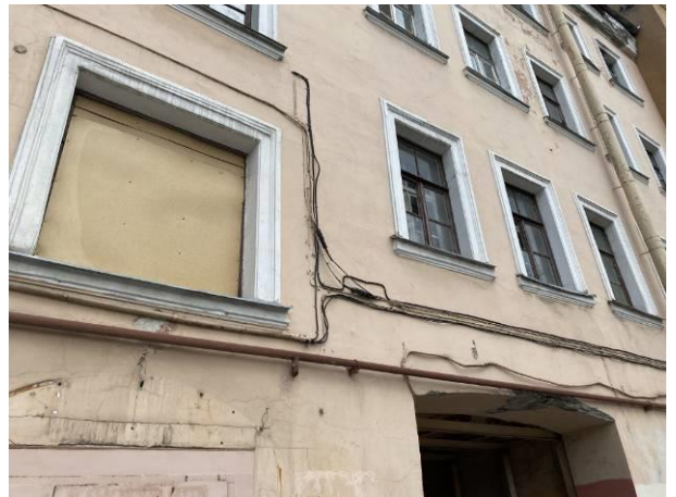
Фото 12. Состояние здания расположения Объекта оценки.
