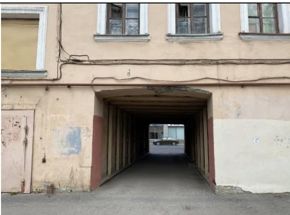
Фото 13. Арка (проезд с пр. Обуховской Оборонь).
