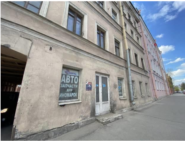
Фото 7. Вид на вход и окна пом. 1-Н с пр. Обуховской Обороны.
