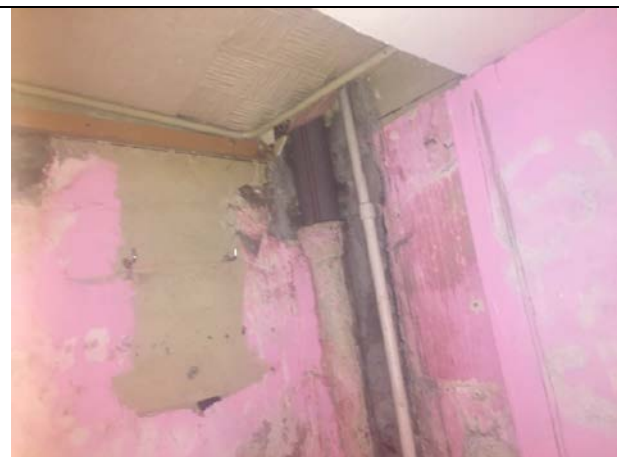
Фото 34. Типичное состояние Объекта оценки
