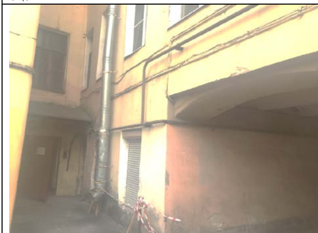
Фото 23. Вход в здание Объекта оценки
