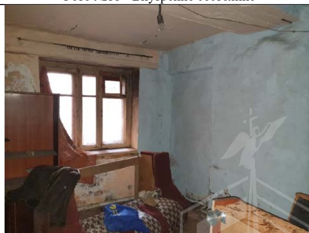
Фото № 12 - Внутренне состояние
