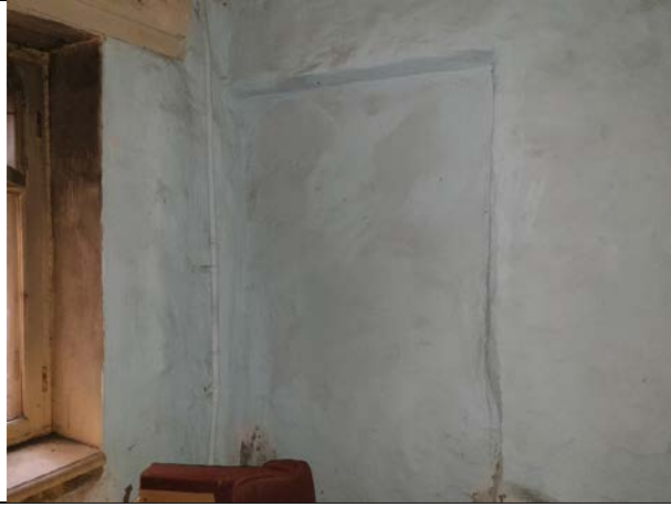
Фото № 13 - Внутренне состояние
