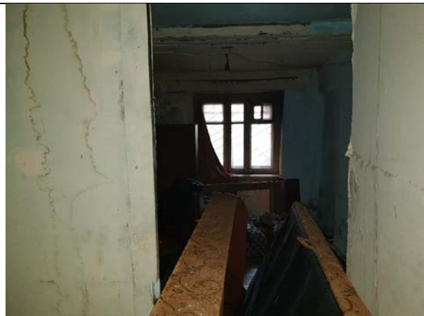
Фото № 5 – Внутреннее состояние
