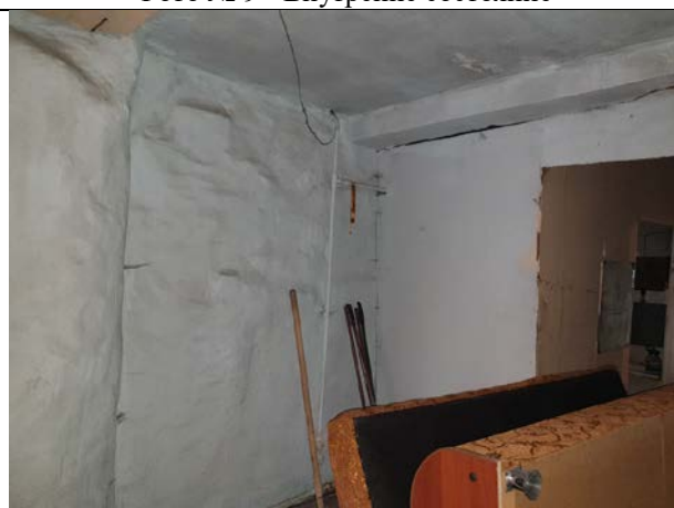
Фото № 11 - Внутренне состояние
