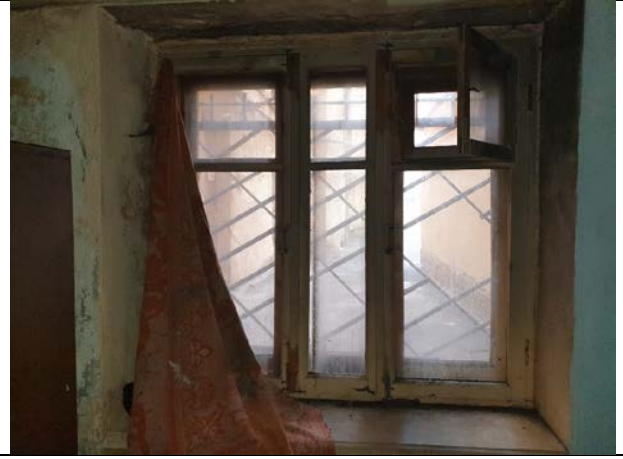
Фото № 14 - Внутренне состояние
