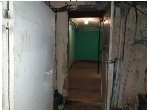
Фото № 8 - Внутренне состояние
