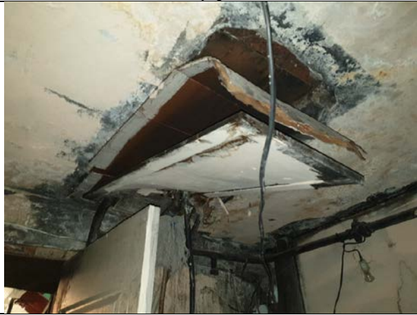
Фото № 15 - Внутренне состояние
