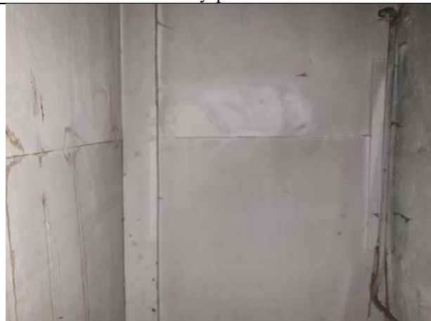
Фото № 7 - Внутренне состояние
