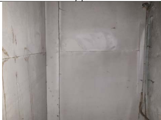
Фото № 7 - Внутренне состояние
