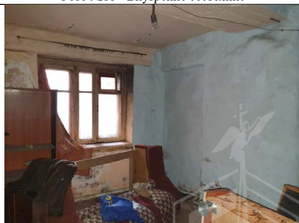
Фото № 12 - Внутренне состояние
