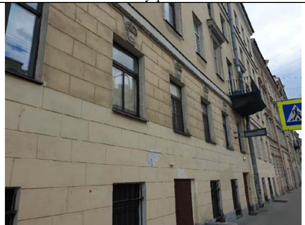
Фото № 18 - Фасад здания
