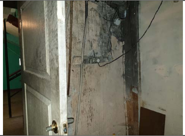
Фото № 16 - Внутренне состояние
