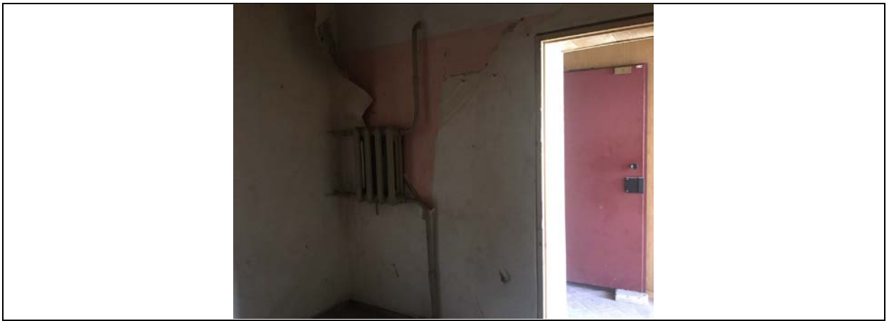
Фото 33. Внутреннее состояние Объекта оценки
