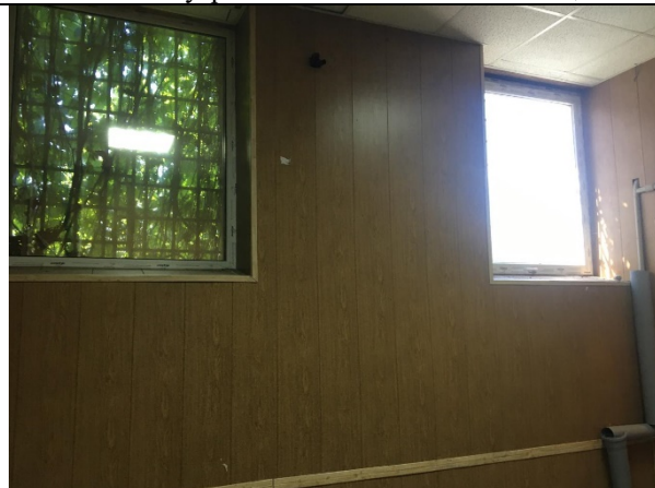
Фото 38. Внутреннее состояние Объекта оценки
