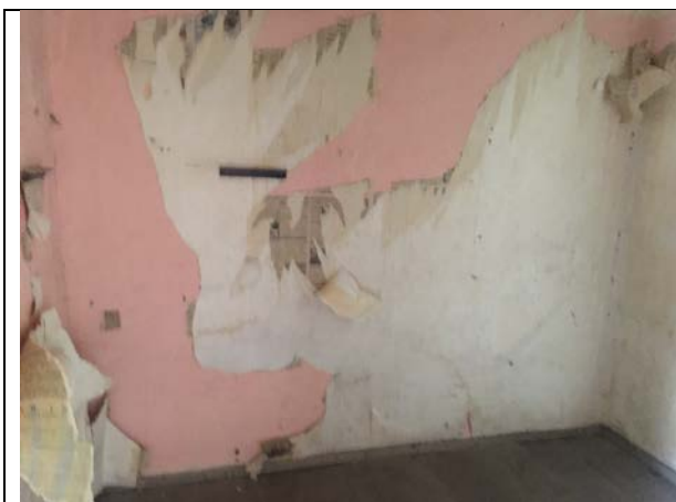
Фото 48. Внутреннее состояние Объекта оценки
