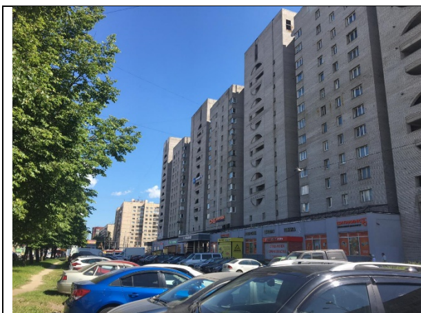
Фото 15. Общий вид жилого дома с улицы
