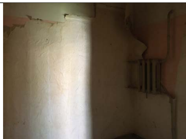
Фото 49. Внутреннее состояние Объекта оценки
