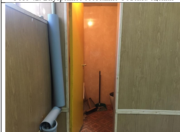
Фото 44. Внутреннее состояние Объекта оценки
