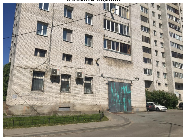
Фото 20. Вход во двор с проспекта, окна Объекта оценки
