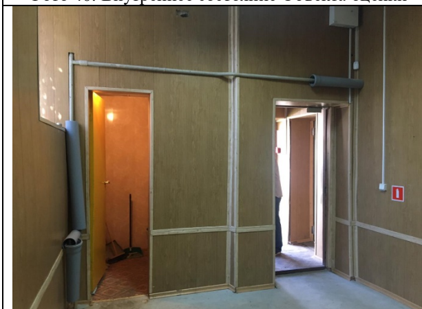
Фото 42. Внутреннее состояние Объекта оценки
