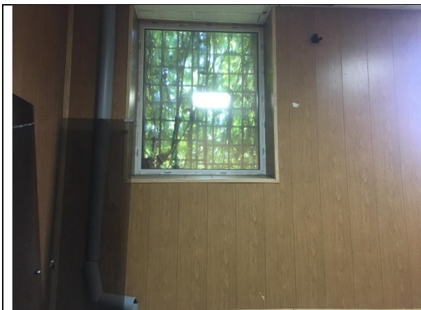
Фото 40. Внутреннее состояние Объекта оценки
