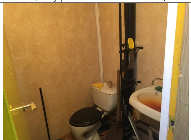
Фото 45. Внутреннее состояние Объекта оценки
