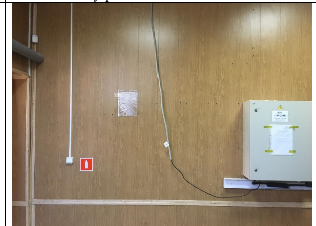
Фото 37. Внутреннее состояние Объекта оценки
