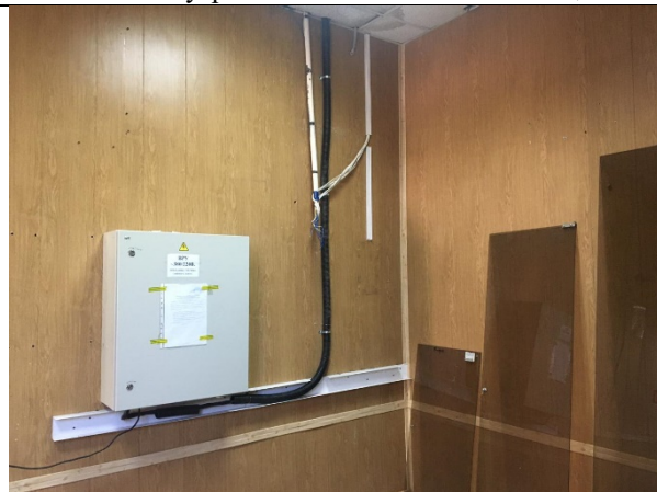
Фото 36. Внутреннее состояние Объекта оценки
