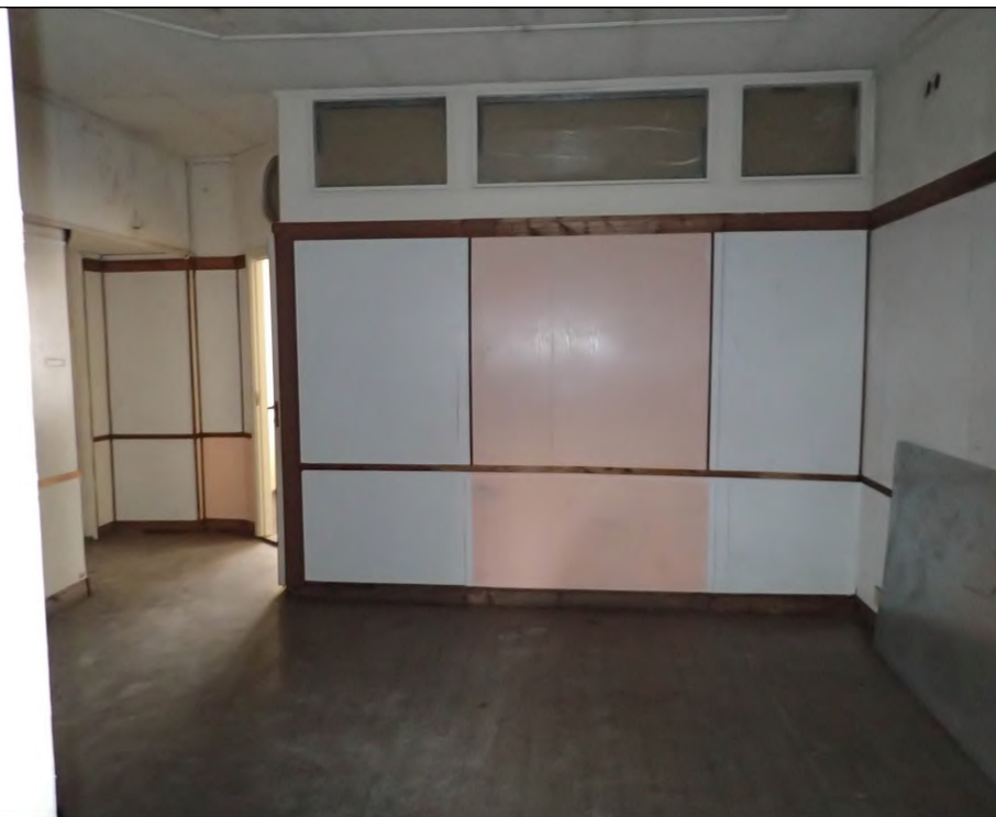
Описание: Вид внутри Объекта
