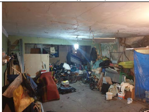
Фото № 3 – Внутреннее состояние
