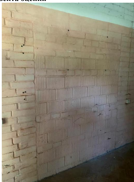
Фото 15. Выход на лестничную клетку – заложен
